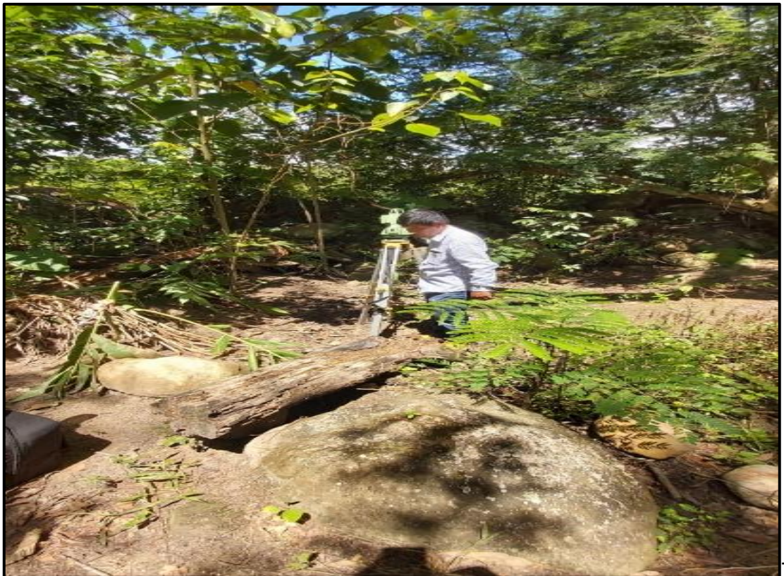
Anexo 10-F: Reconocimiento del área, para el estacionamiento de la estación total
