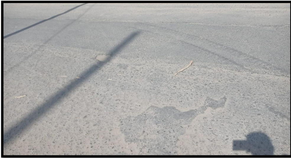
Figura 12. Parqueo y acometidas de servicio
