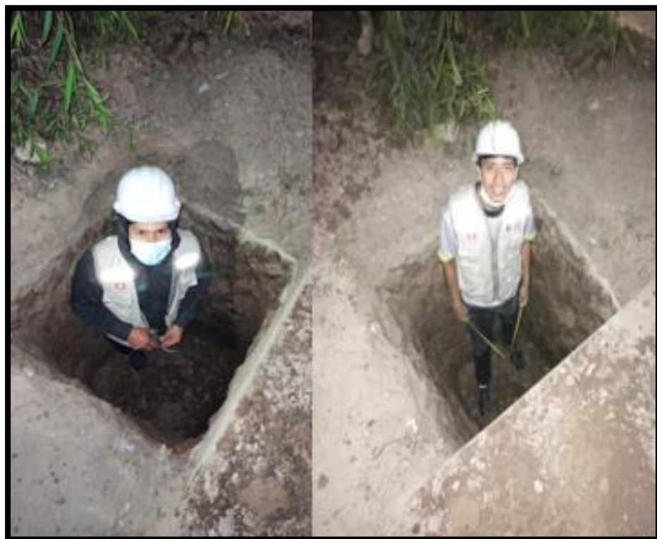
Figura 21. Excavación de calicata
