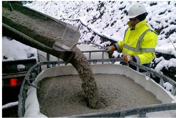
Figura 1. Mezcla de concreto.
