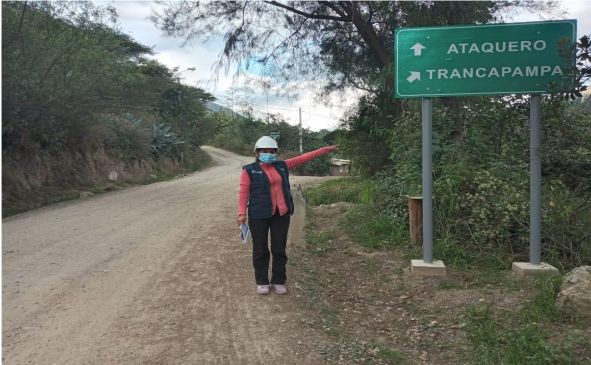
Figura 30. Inspección a la carretera Ataquero-Trancapampa
