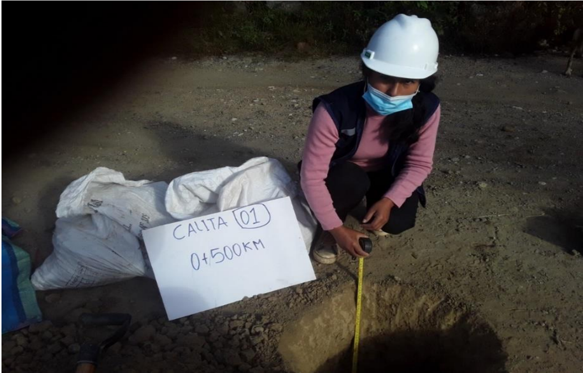
Figura 34. Calicata C – 01 que se ha realizado en la subrasante 00+500 km.
