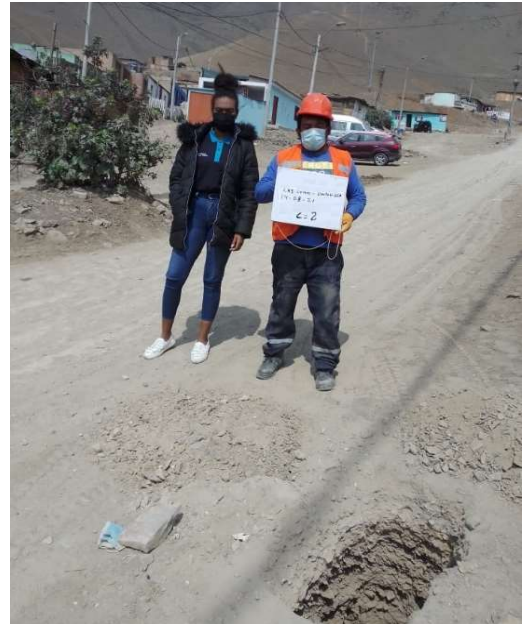
Realización de calicata
