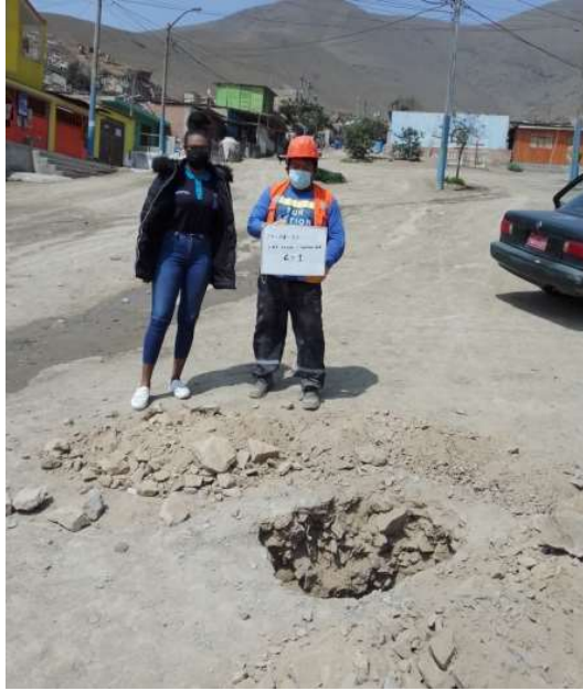
Realización de calicata
