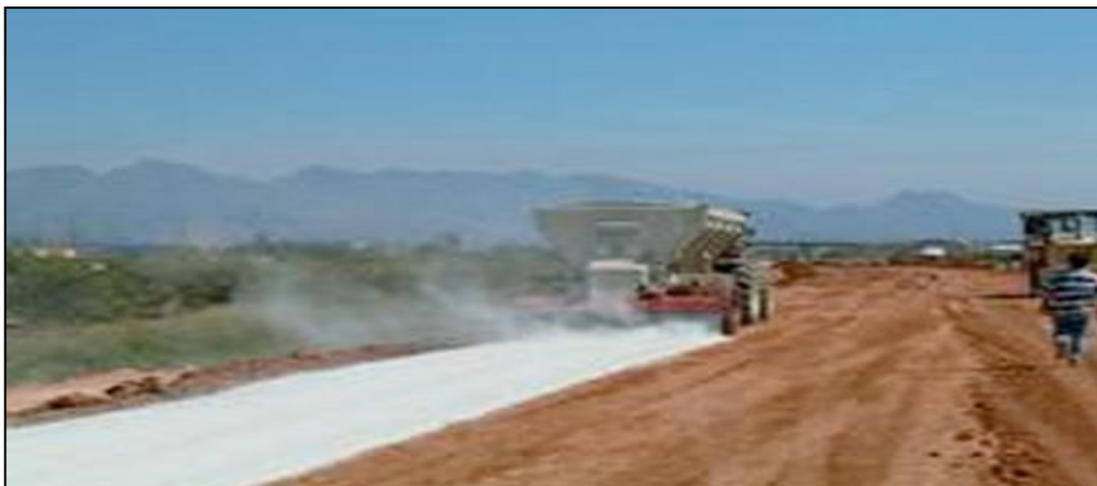
Figura 5: Estabilización de suelo con Cal
