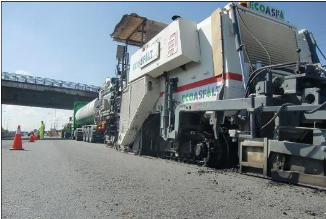
Figura 4: Estabilización de suelo con Cemento
