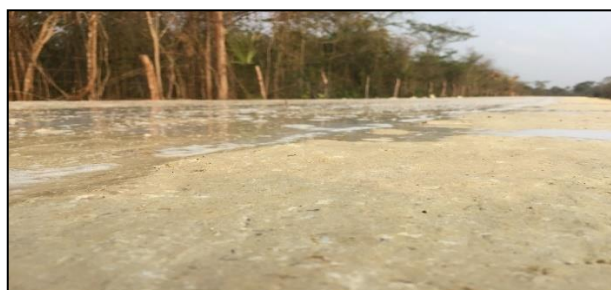
Figura 06: Estabilización de suelo con Terrasil
