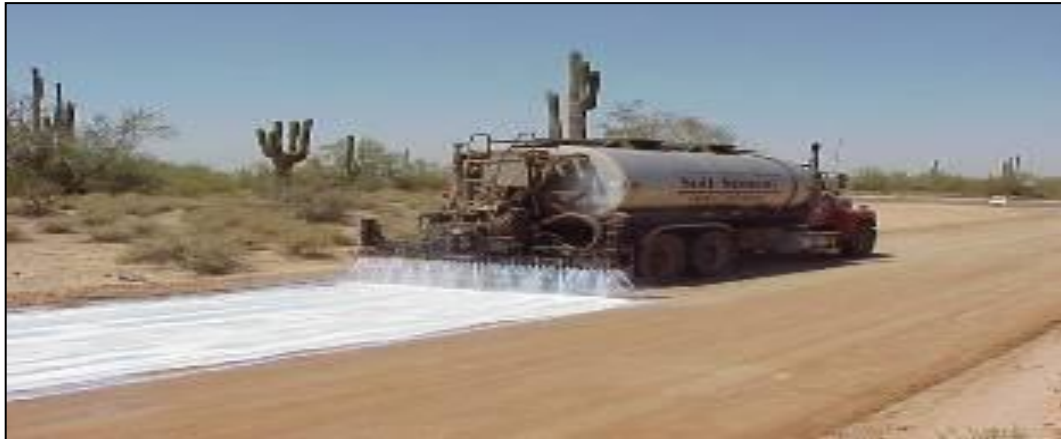
Figura 1: estabilización de suelos con aditivos químicos
