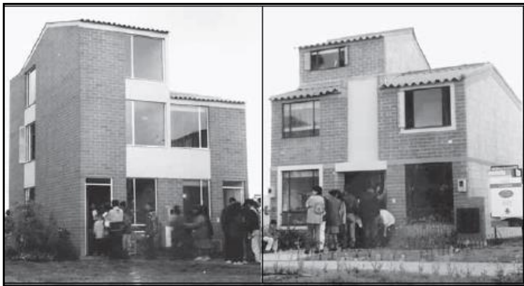
Figura 21. Tipologías de viviendas desarrolladas en la ciudadela el Recreo
