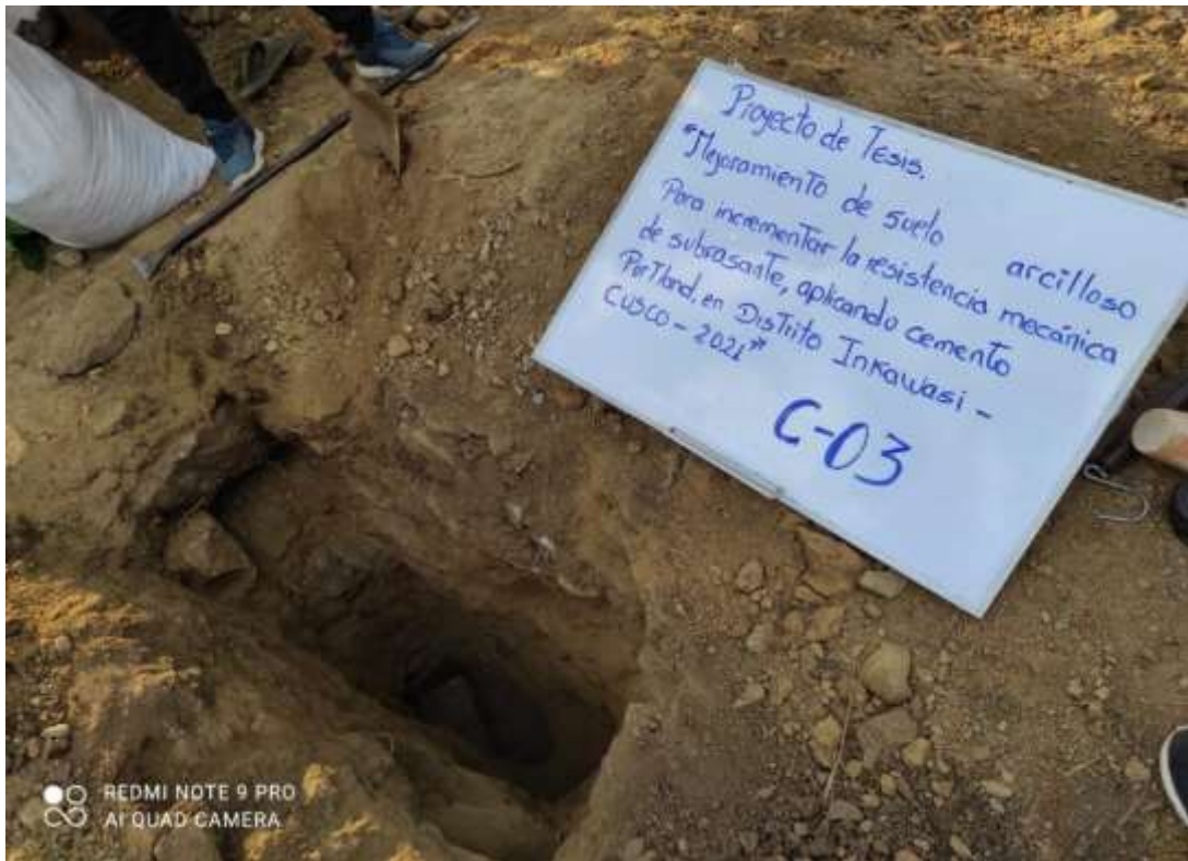
Figura 9. Excavación y toma de muestras
