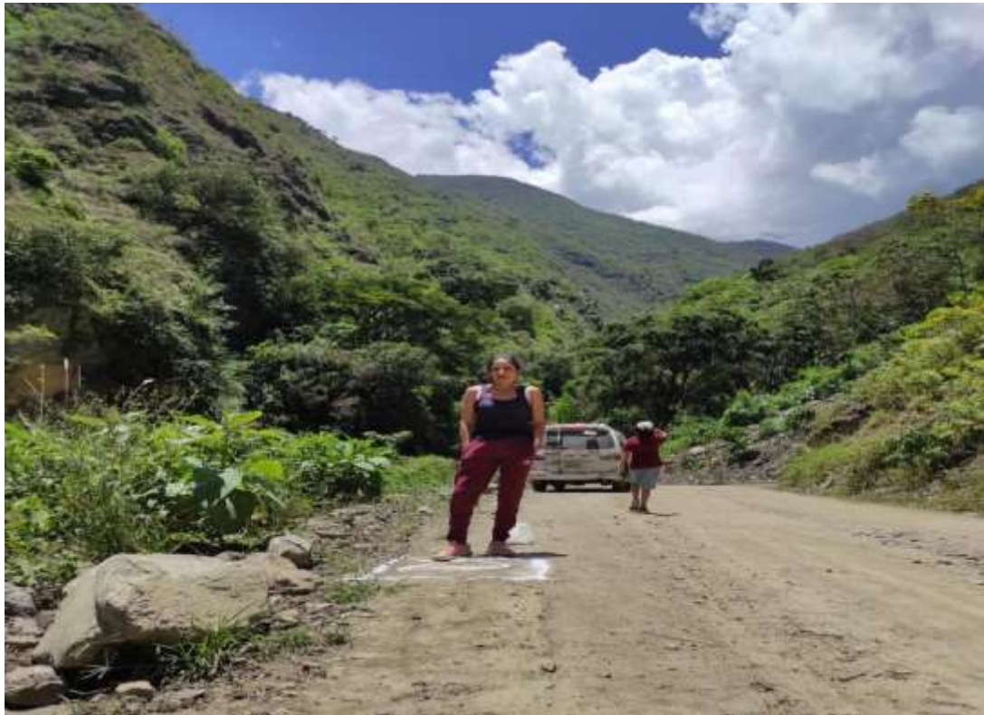
Figura 7. Posición de la calicata 02
