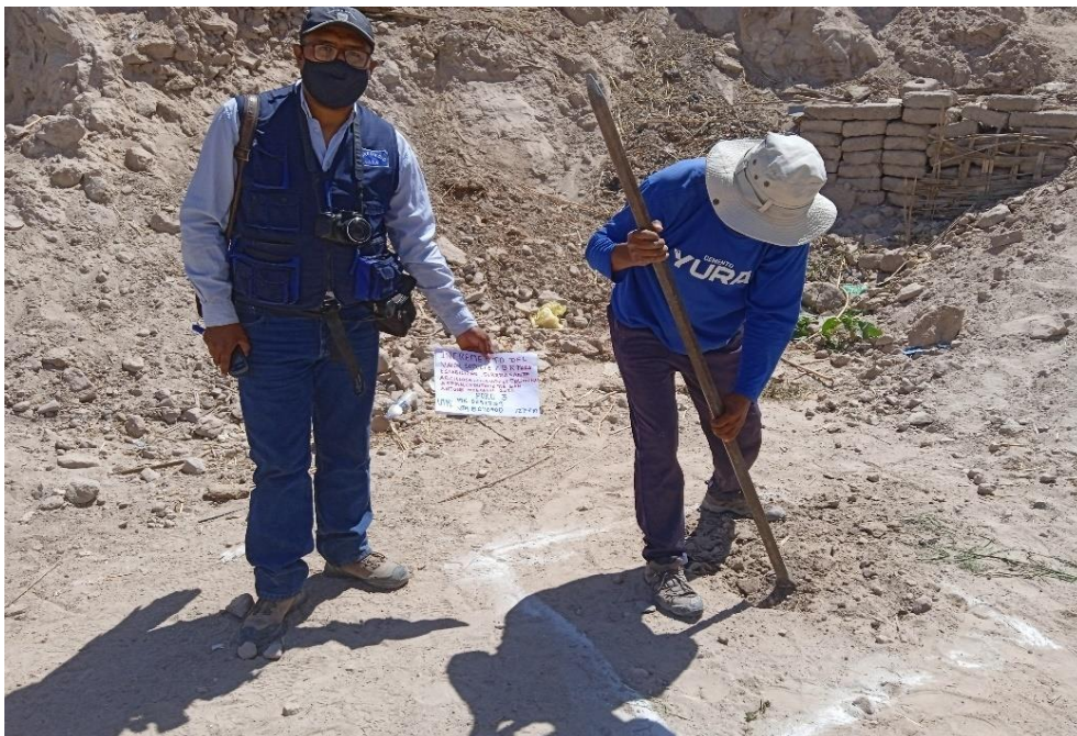
Figura 2: Excavación de calicata N 02 de la zona de estudio Fuente: Elaboración propia
