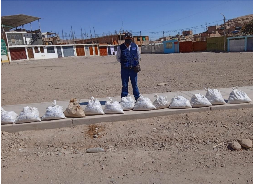
Figura 7: Muestras extraídas de la calicata N° 2 en el centro poblado de San Antonio Moquegua Fuente: Elaboración propia
