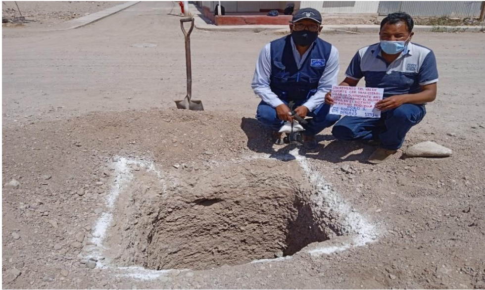
Figura 01: Excavación de las calicatas en el centro poblado de San Antonio Moquegua Fuente: Elaboración propia
