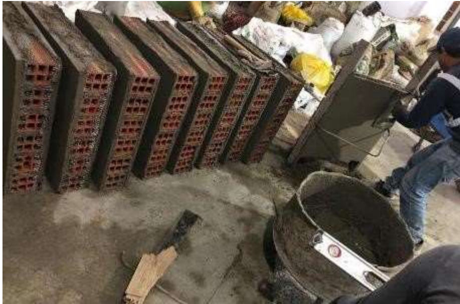
Figura 13. Finalización de los muretes tradicionales y reforzado
