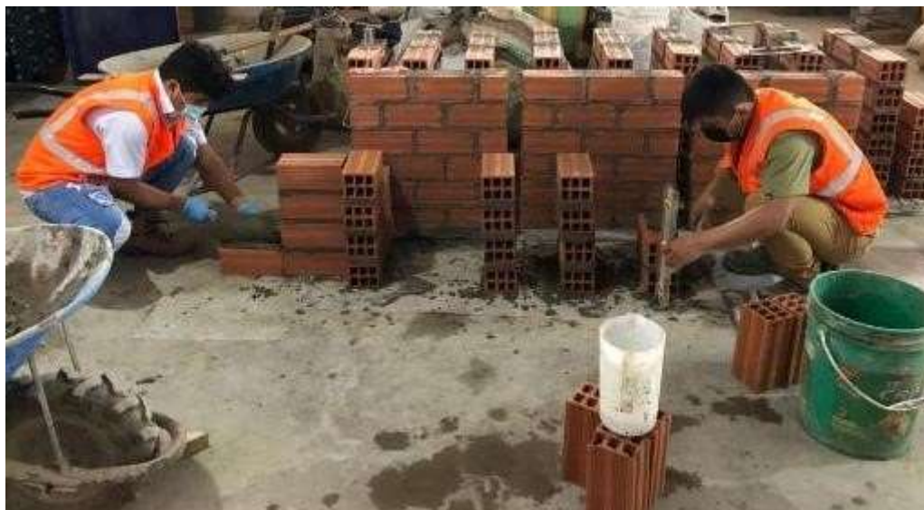
Figura 16. Procedimiento de pilas con malla de tarrajeo
