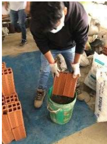
Figura 8. Mojado de los ladrillos en muretes
