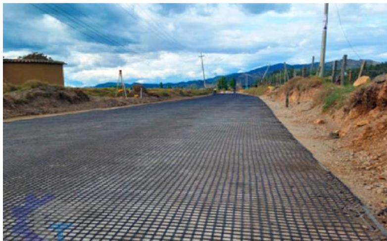
*Figura 2: Instalación de Geomallas Biaxiales*
