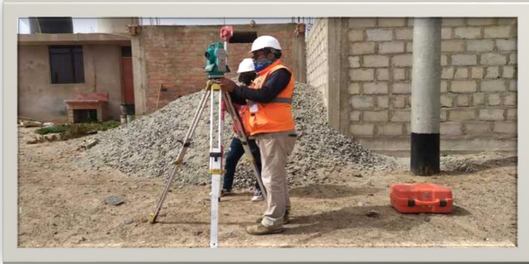
Foto 8: Se aprecia al operador de equipo de estación total, realizando el levantamiento topográfico en la Av. "D" del AA.HH los Algarrobos.
