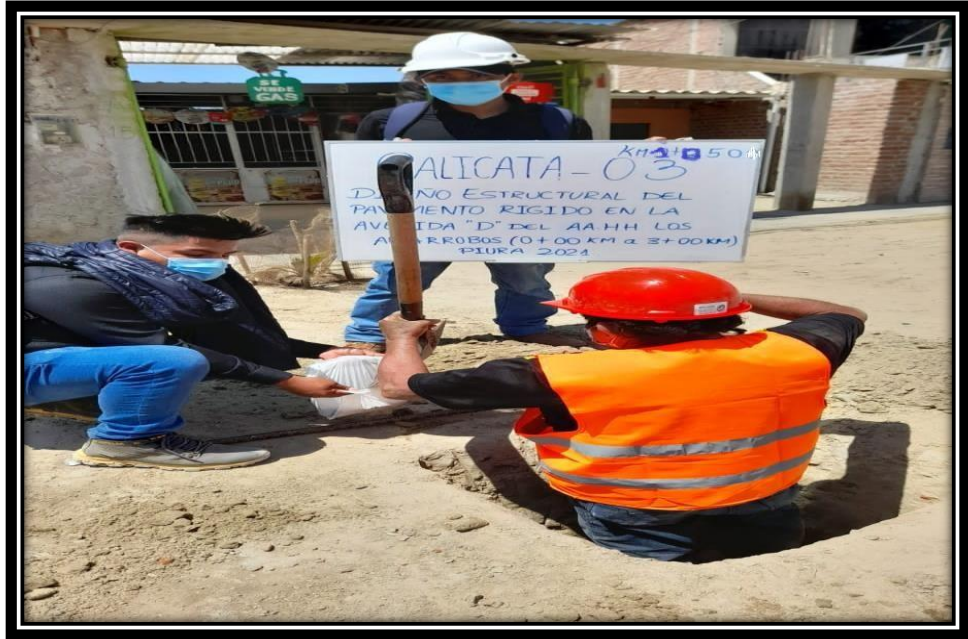
✓ Foto 4: (Calicata 03)- km 1+050, de la Avenida D AA.HH Los Algarrobos.
