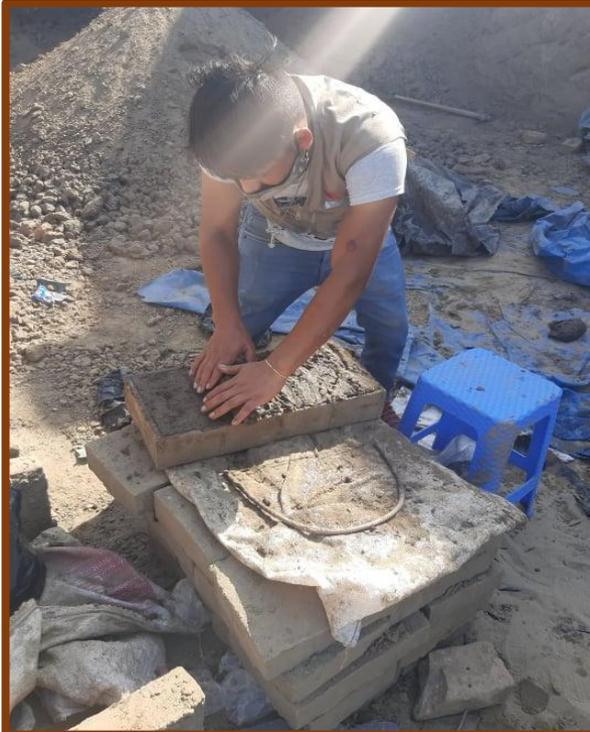
Figura N°04: Se empezó a realizar el moldeo para los ladrillos de arcilla.
