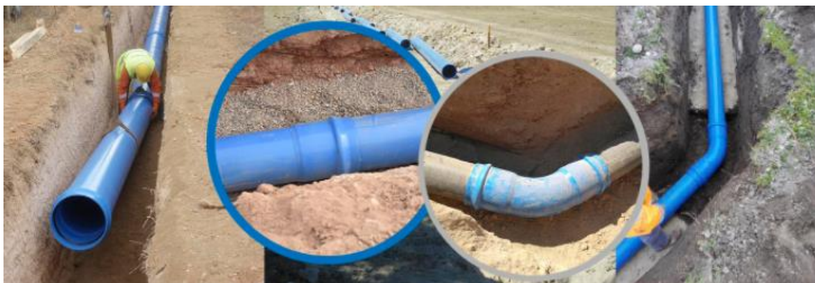
FIGURA N° 11 Imágenes de Instalación de Tuberías PVC-O
