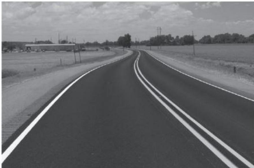
*Figura 4* Pavimento Flexible. Tomada de «Pavement Design: Materials, Analysis, and Highways», por Rashad y Tarefder, 2020, p. 23.
