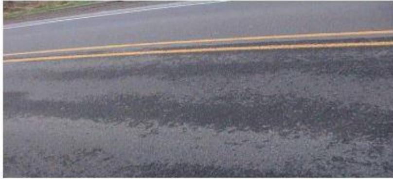
*Figura 13* Exudación en Pavimento. Tomada de «Identificación y Evaluación de las fallas superficiales en los pavimentos flexibles de algunas vías de la ciudad de Barranca – 2017.», por Zevallos, 2018, p. 34.
