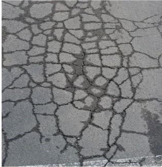
Figura 11 Falla de Piel de Cocodrilo. Tomada de «The constructor Building ideas», por The Construction Encyclopedia, 2017, p. 1.
