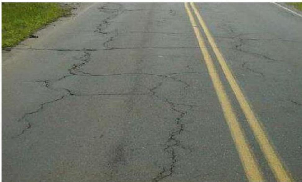
*Figura 14* Fisuras en Bloque. Tomada de «Identificación y Evaluación de las fallas superficiales en los pavimentos flexibles de algunas vías de la ciudad de Barranca – 2017.», por Zevallos, 2018, p.
