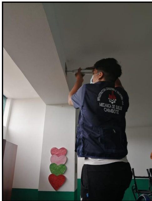
Figura 20: Ensayo de esclerometría en viga
