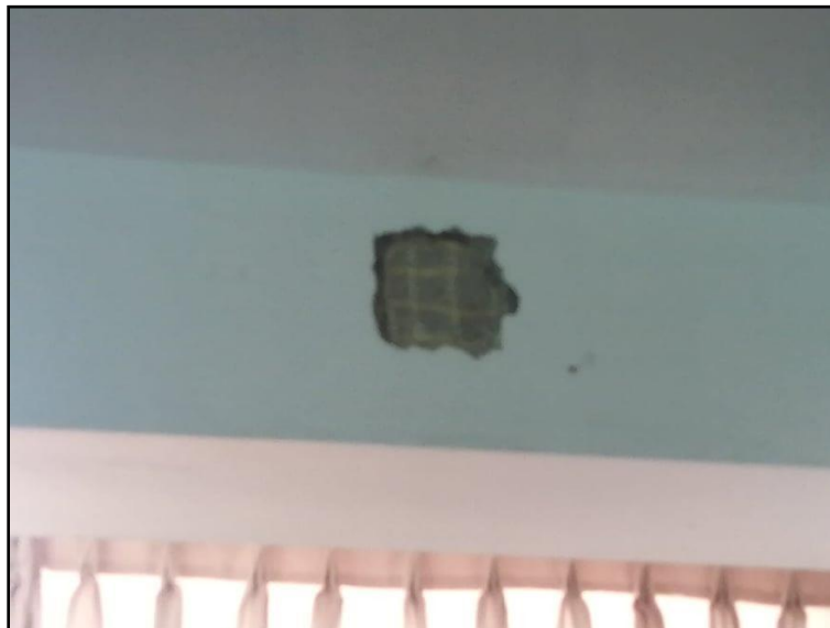
Figura 18: Corte del tarrajeo y trazos de 5cm x5cm para el ensayo de esclerometría en vigas
