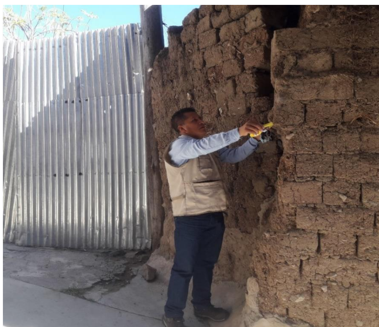
Fotografía 3. Toma de mediciones y análisis de fallas de los muros de adobe de viviendas en estudio.
