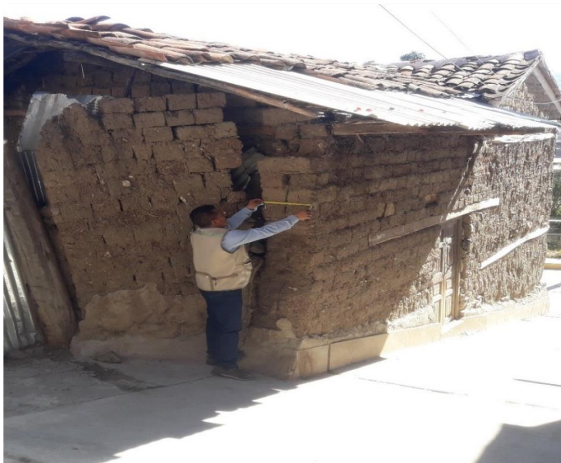
Fotografía 3. Toma de mediciones y análisis de fallas de los muros de adobe de viviendas en estudio.
