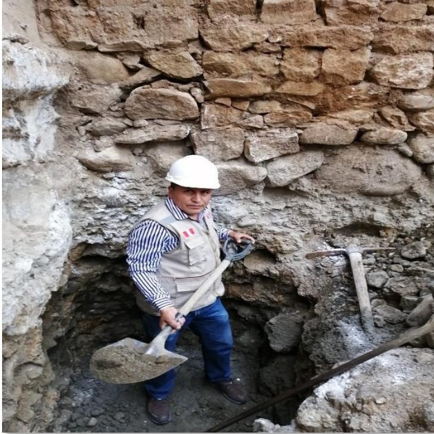
Fotografía 5. Calicata N°01 para obtención de muestras para análisis y estudios en laboratorio.
