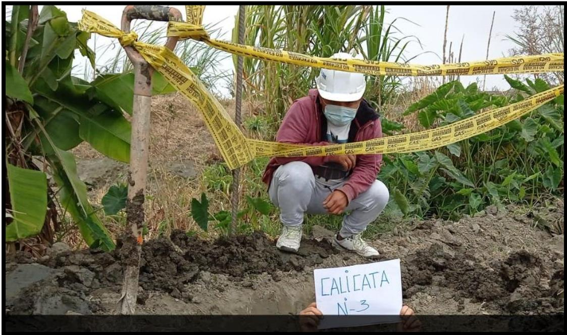
Foto 02: Excavación de calicata N°02
