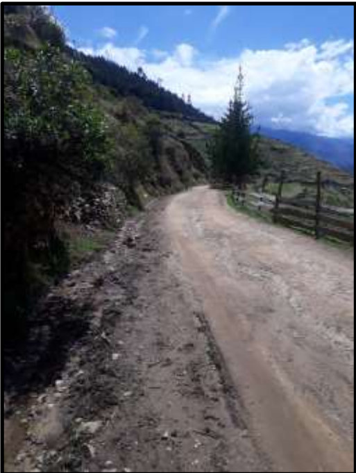
Figura 3. Vista de carretera
