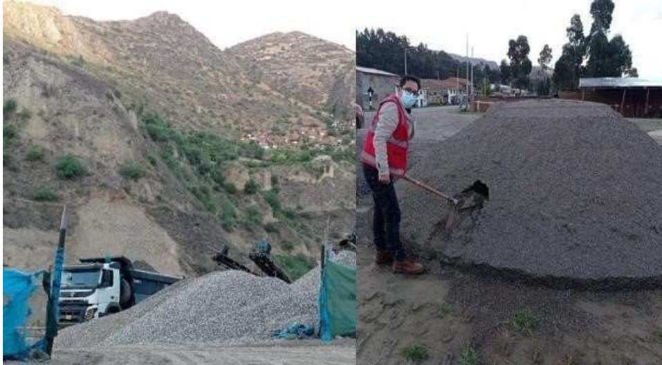
Figura 12. Extracción de agregados cantera - rio santa tacllan - rumichuco.
