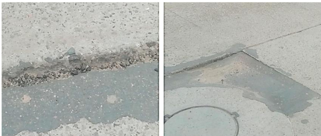
Figura 14: Deterioro Superficial
