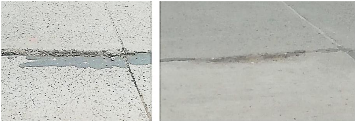
Figura 21: Nivelación de berma
