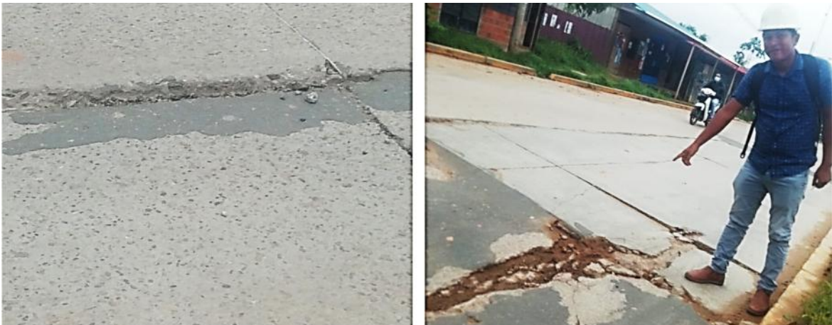
Figura 20: reparación de espesor
