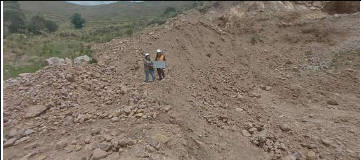
Vista panorámica de la cantera ubicada en la progresiva Km 7+350
