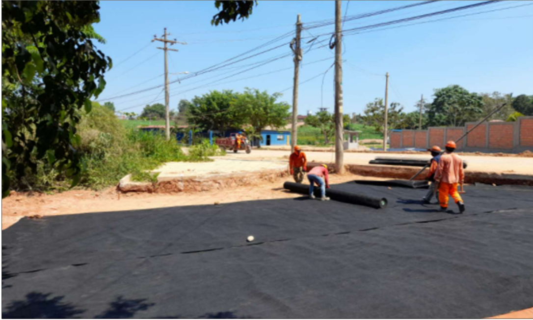
Colocación de la Geomanta
