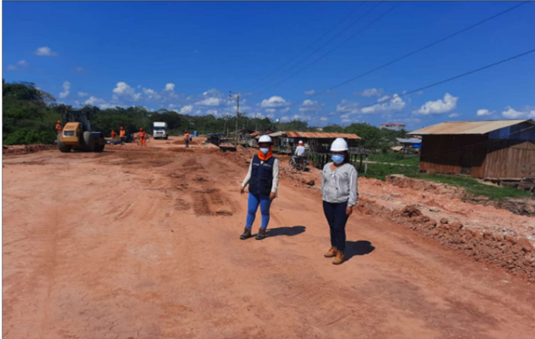
Relleno y compactado de la vía
