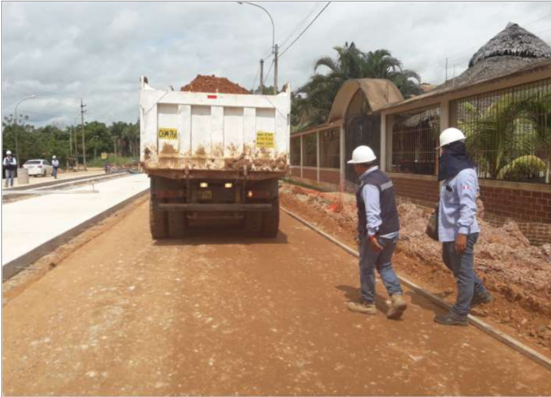
Compactación de la vía.
