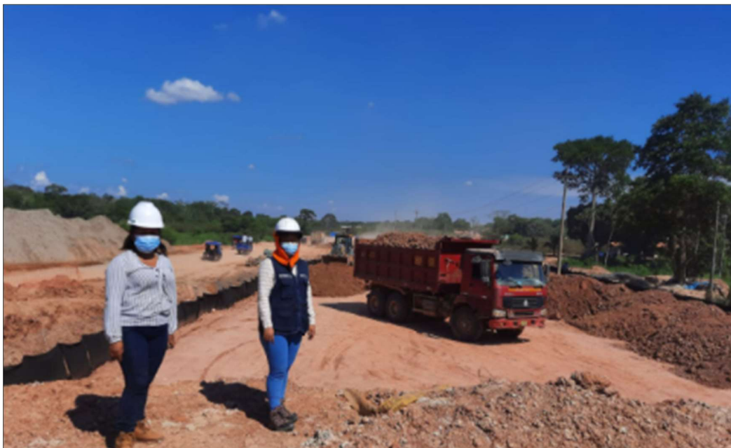
Relleno y Mejoramiento de la vía.
