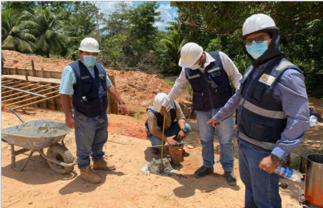
Vertido de Concreto de la vía de pavimentación y extracción de la muestra para el Slump del concreto.
