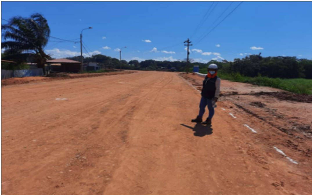
Mejoramiento de la vía.
