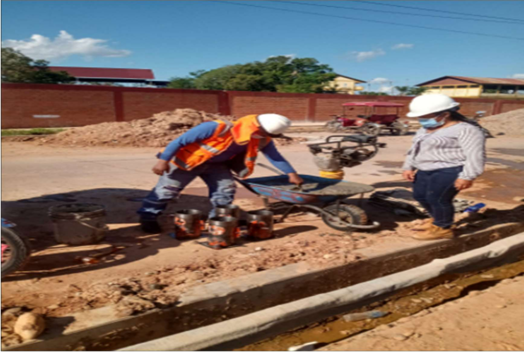
Vertido de Concreto de la vía de pavimentación y extracción de la muestra para las probetas de resistencia de concreto.
