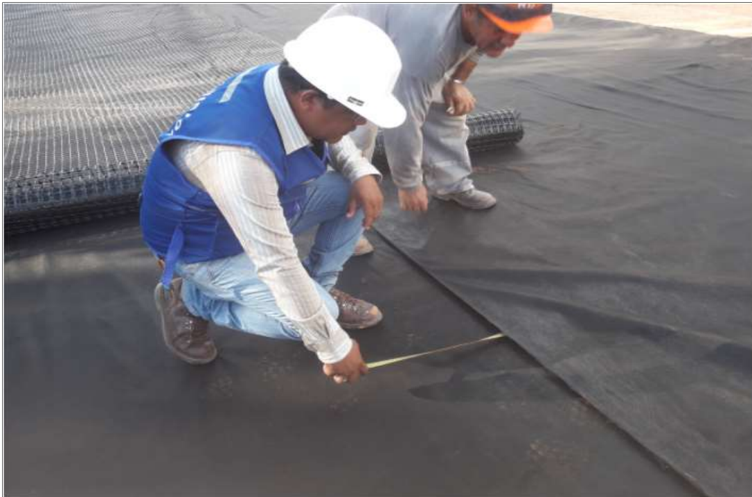
Colocación de la Geomanta y Geotextil.
