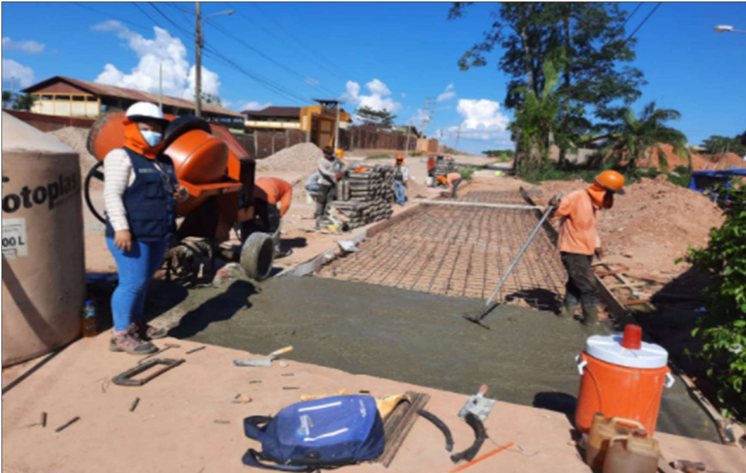
Vertido de Concreto de la vía de pavimentación y extracción de la muestra para el Slump del concreto.
