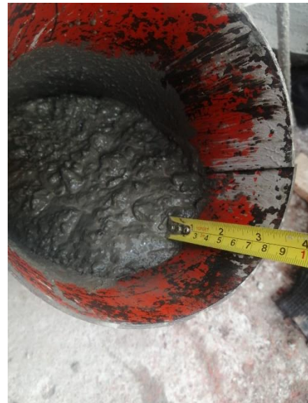
Fotografía 4. Elaboración de mortero intencionalmente inclinada.
