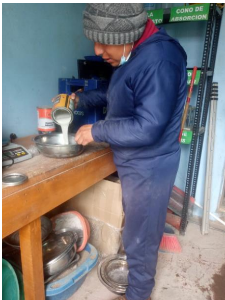
Fotografía 3. Mezcla de la parte A y B del adhesivo Sikadur 32 gel.
