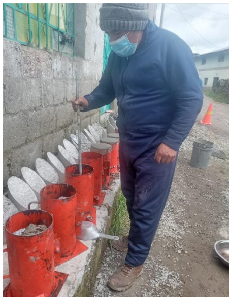
Fotografía 3. Varillado por capas de concreto fresco
