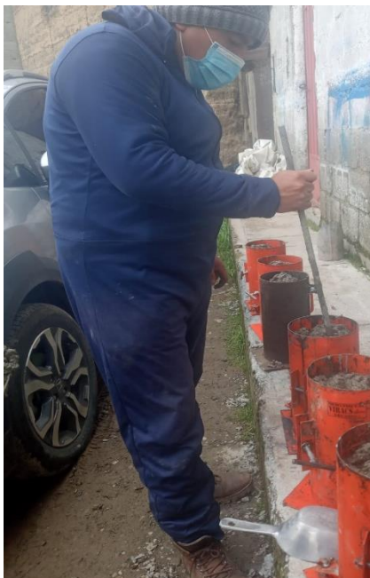
Fotografía 3. Varillado del mortero por capas
