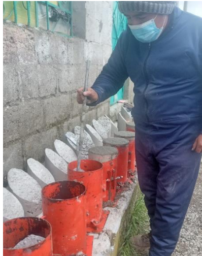
Figura 21. Moldes antiguas, aplicando concreto fresco (segunda etapa).
