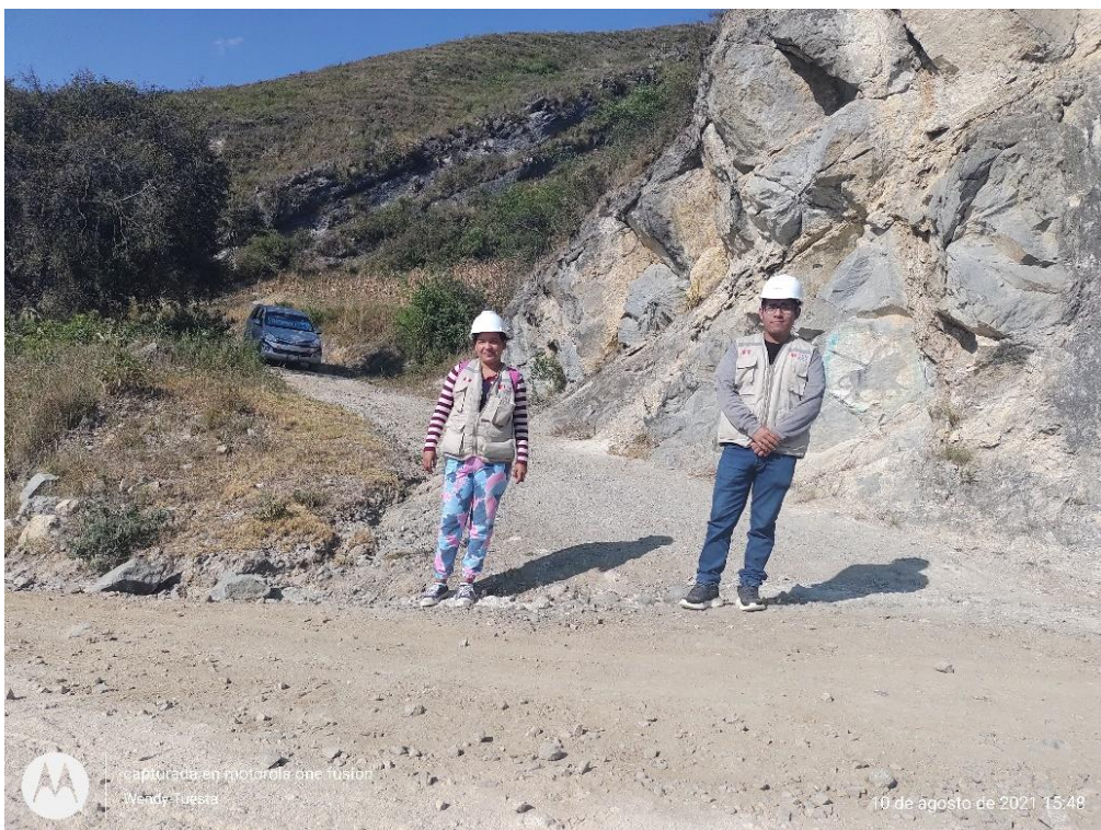
Figura 13: Parte final del Tramo “Cruce Yanazara”. Se evidencia que el tipo de material predominante es la roca fija.
