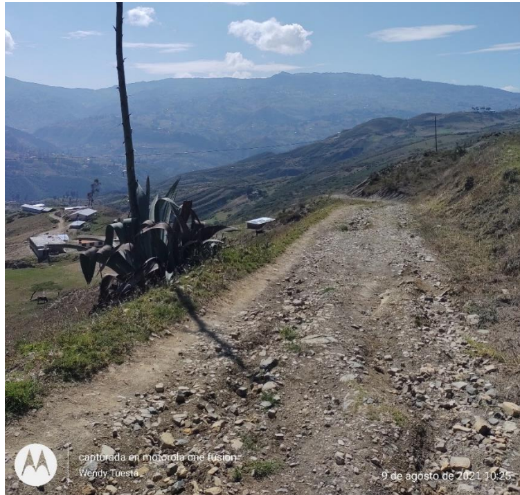
Figura 06: Trocha Carrozable en mal estado.
