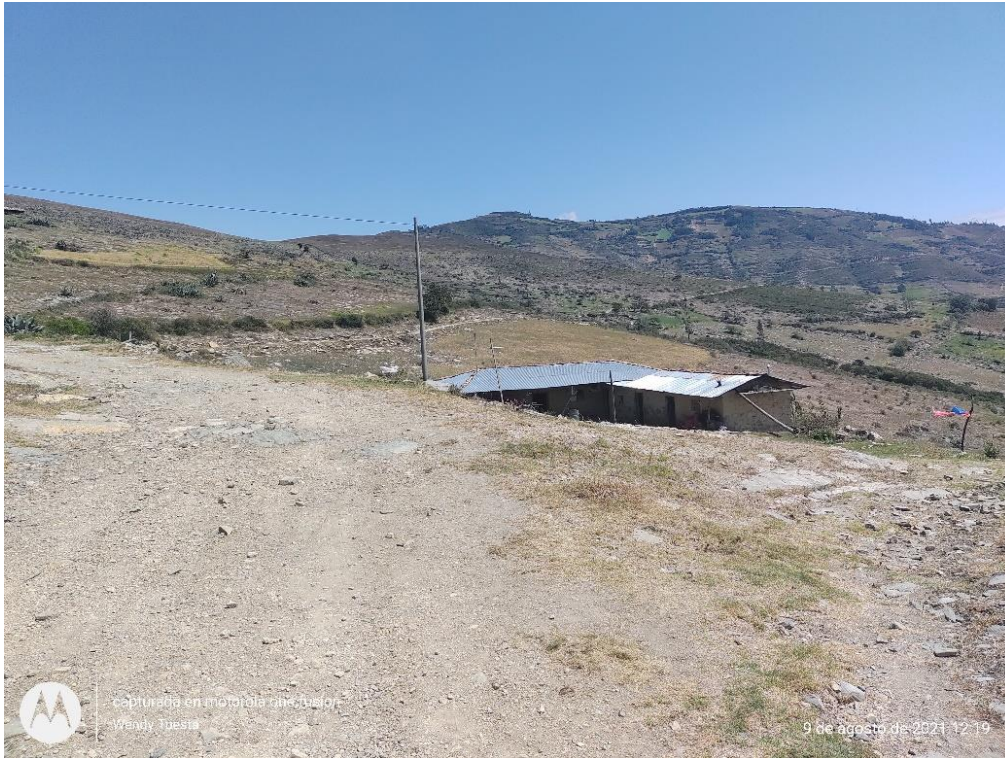
Figura 08: Estado de las viviendas de adobes.
