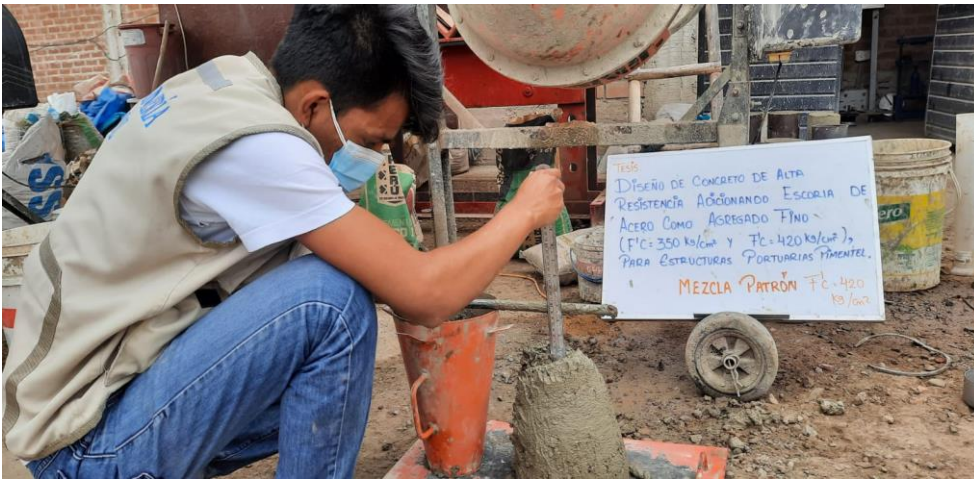
Figura 13. Ensayo del Slump
