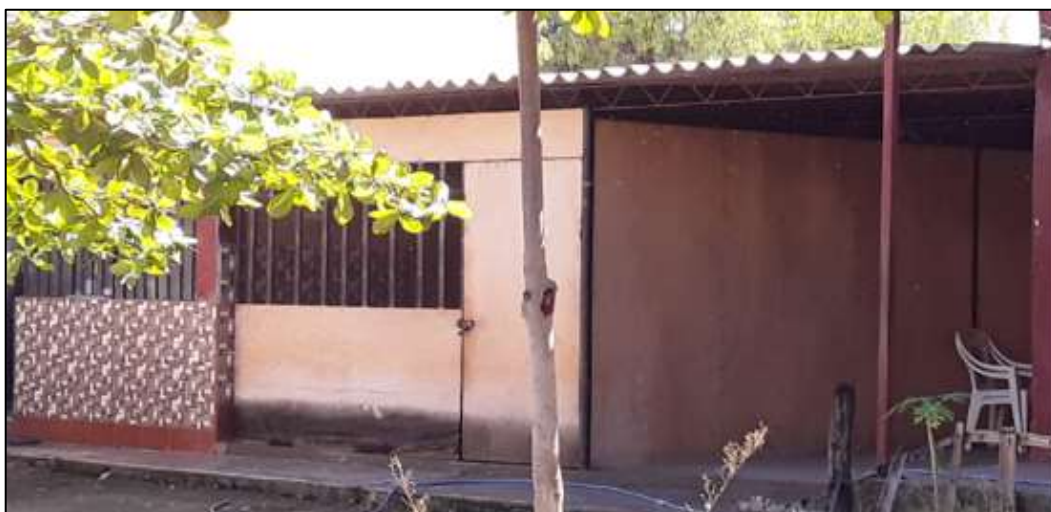
Figura 6. I.E. N° 10147, diagnóstico del estado actual del módulo comedor - cocina escolar, 2021
