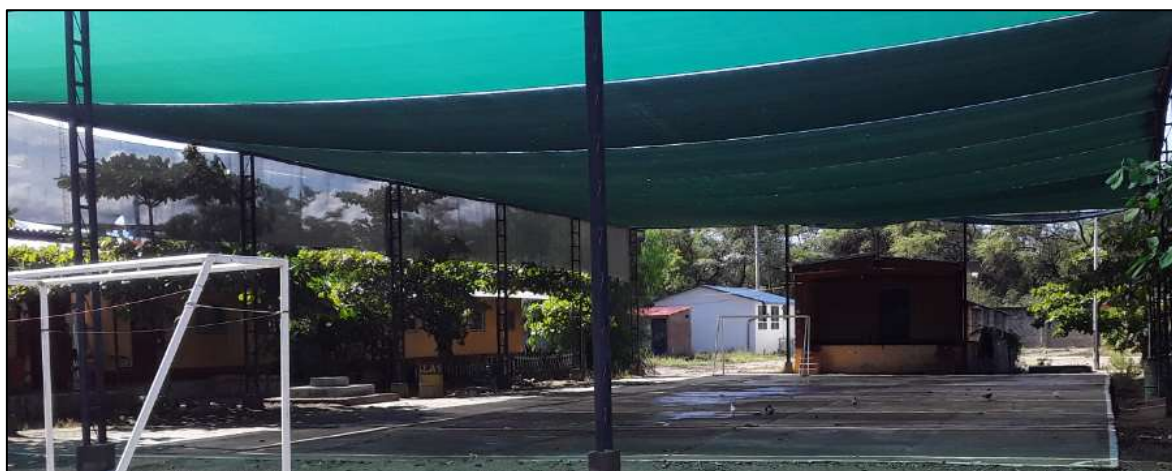
Figura 2. I.E. N° 10149, diagnóstico del estado de la losa deportiva, 2021
