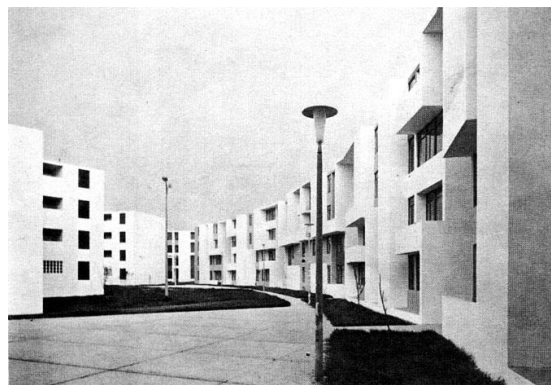
Figura 13- Imagen Urbana, Fuente: REVISTA: Conjunto Habitacional Palomino. (1967). El Arquitecto Peruano, 347-348, 36-39
