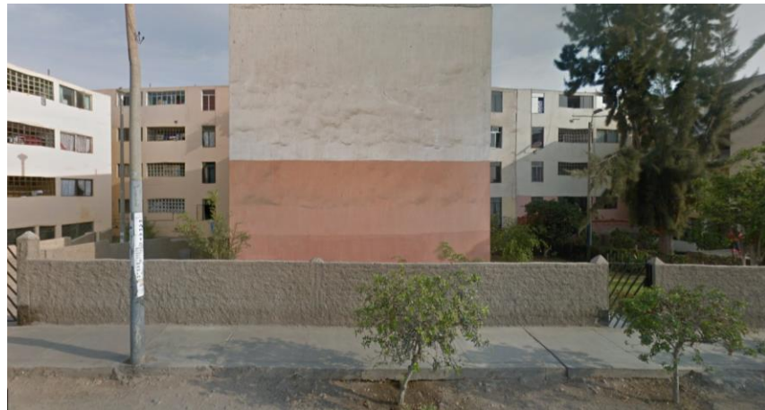
Figura 8- Visibilidad frente al proyecto, Fuente: Google maps
