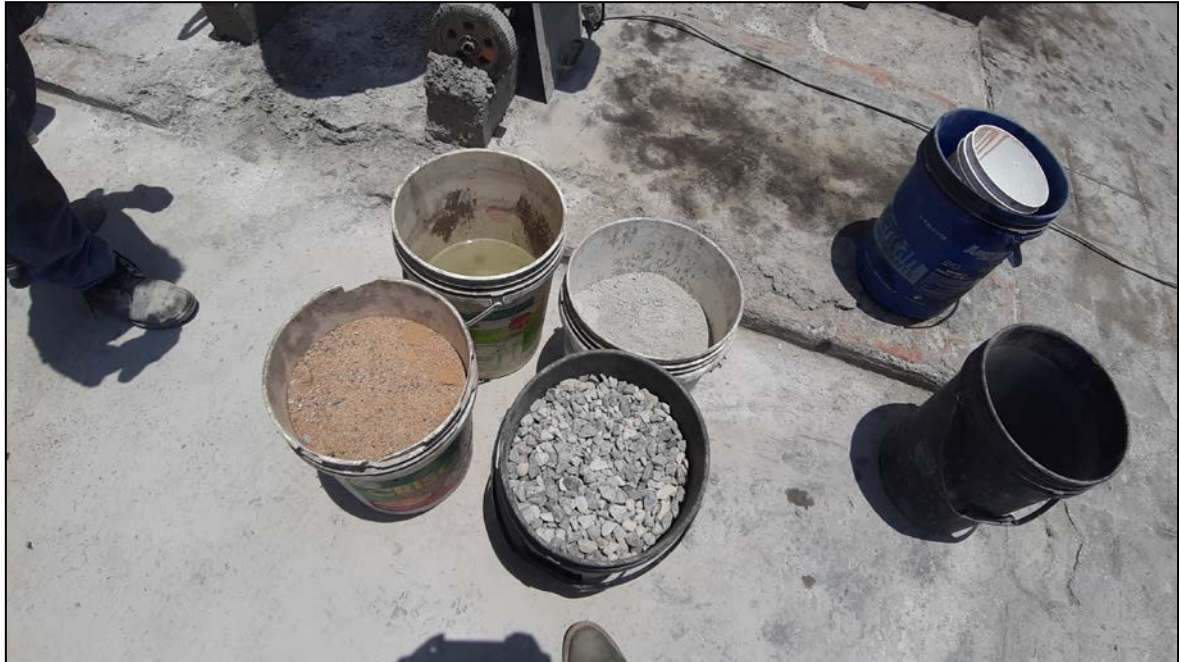
Figura 61. Materiales para elaborar el concreto según el diseño de mezcla.
