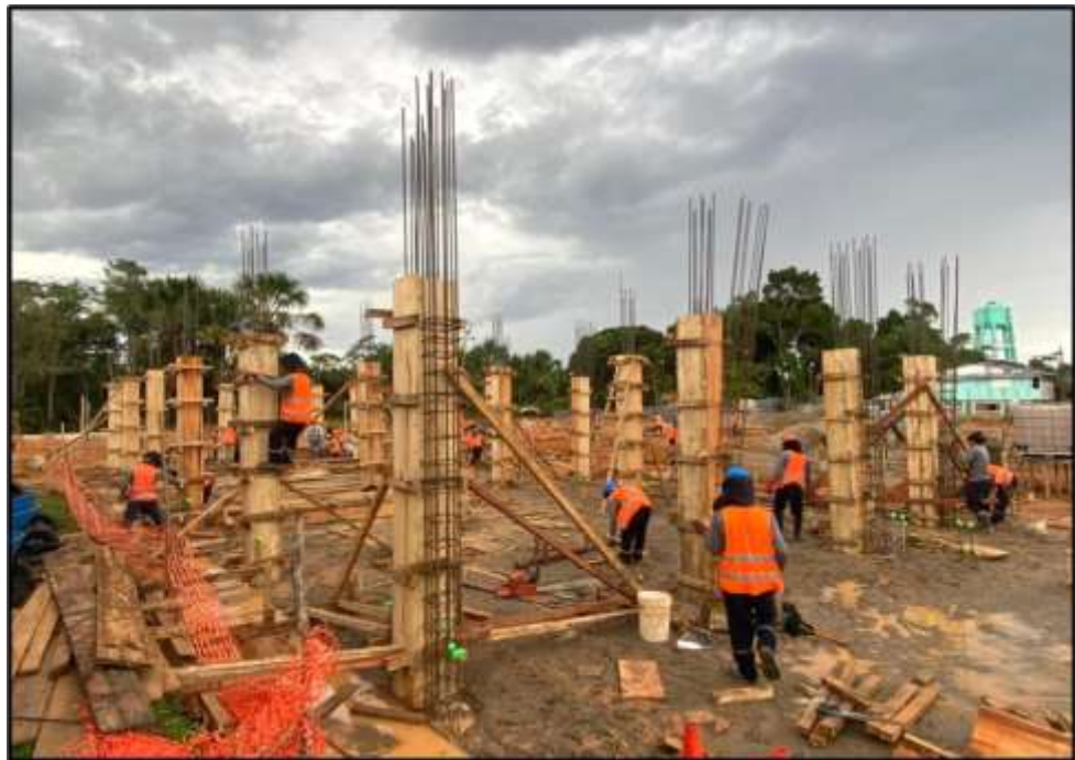
Sector 03 – Módulo C – Encofrado de Columnas
