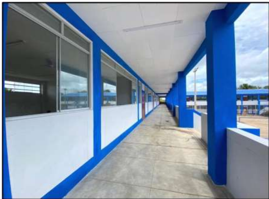
Módulo A – Sector 01 – Fase de Acabados
