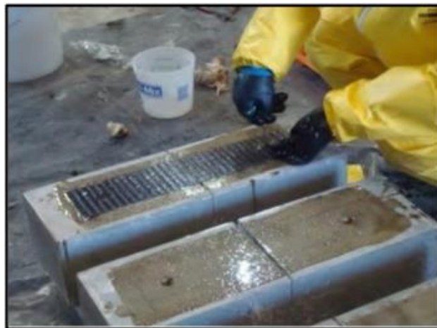
Figura 26. Proceso de la aplicación de epóxico en los agujeros Fuente: Guillermo La Torre y Silva (2019)
