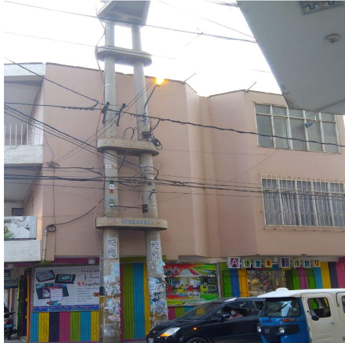
Figura 34. Vista lateral del edificio Galerías Ayacucho
