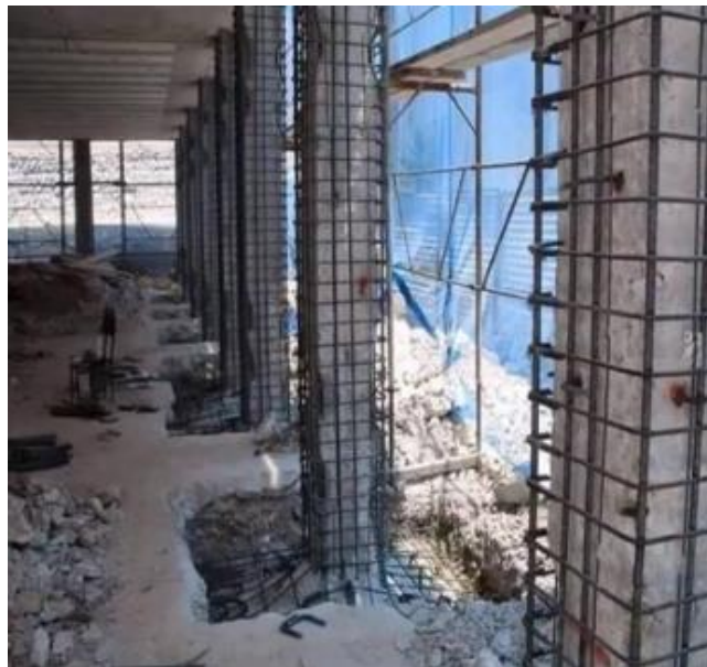
Figura 29. Encamisado de columna
