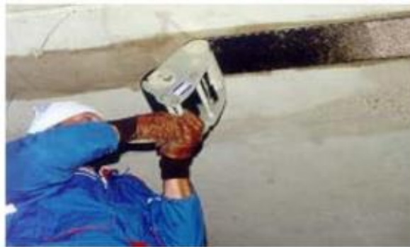
Figura 24. Proceso de desenrollado de la fibra de carbono.
