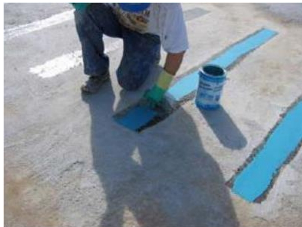
Figura 23. Proceso de colocación del adhesivo sobre la superficie.
