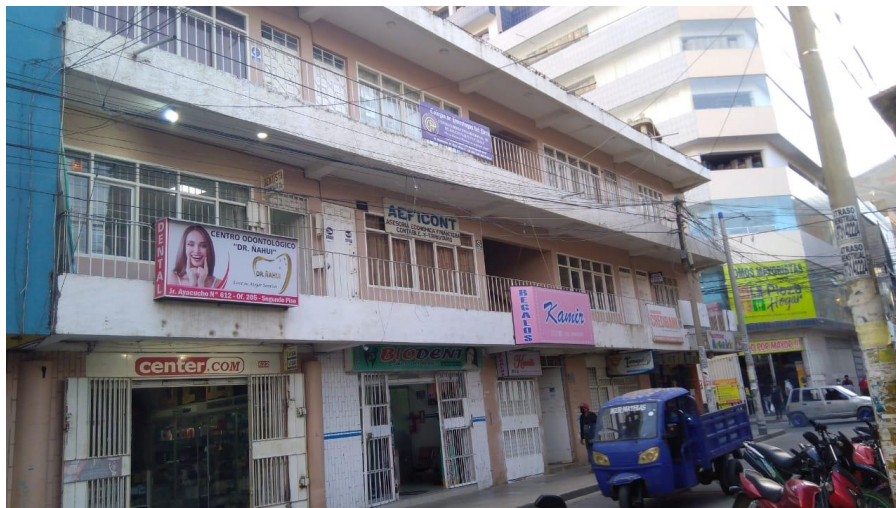
Figura 33. Vista frontal del edificio Galerías Ayacucho
