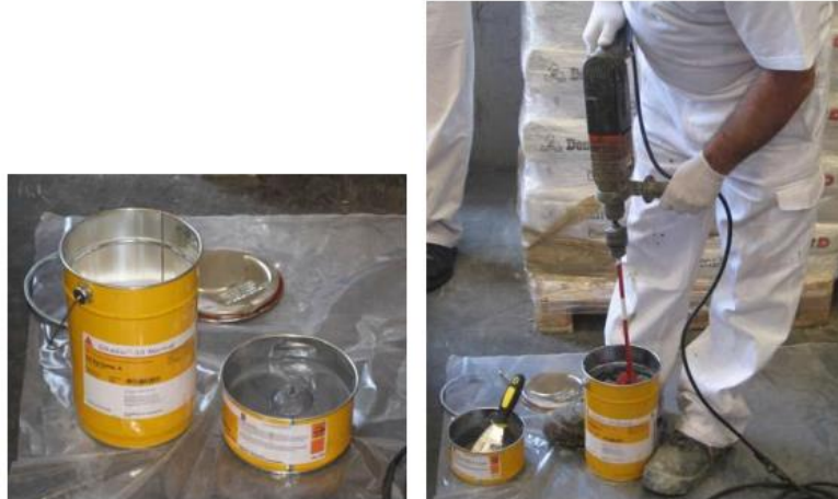
Figura 22. Proceso de mezclado.
