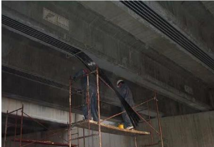
Figura 10. Fibra de carbono en refuerzo a flexión
