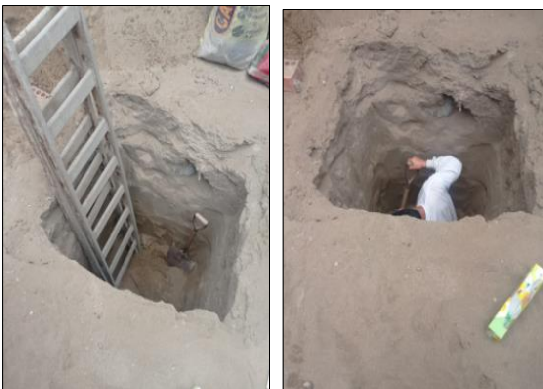
Figura 4. Ejecución de calicata
