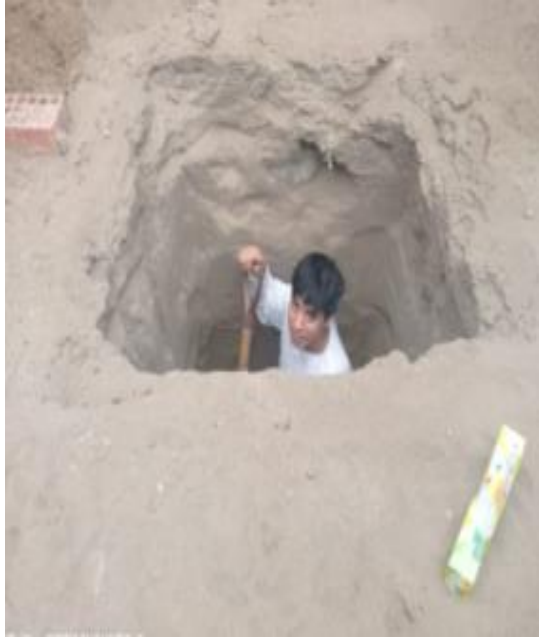
Figura 23. Elaboración de calicata
