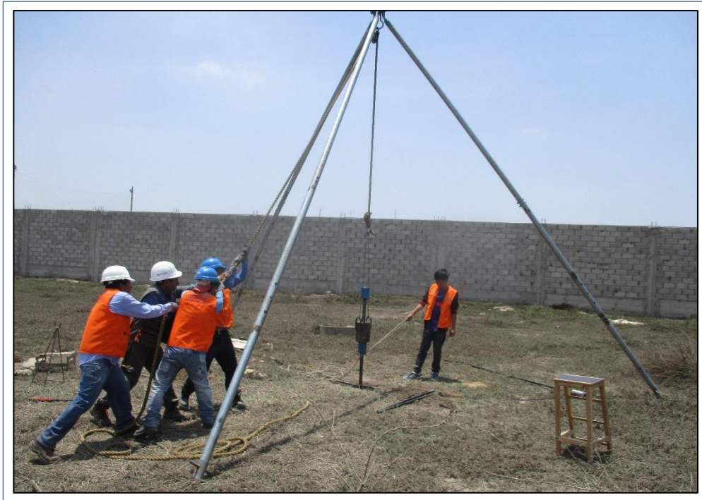
Figura 51 Ensayo de Penetración Estándar realizado en la Habitación Urbana “Miguel Sánchez Gonzales” – La Victoria – Chiclayo.
