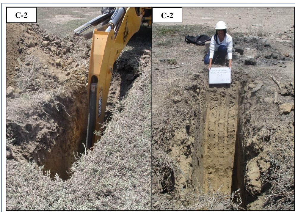
Figura 46 Extracción de muestras de Calicata C-2 de la Habilitación Urbana “Miguel Sánchez Gonzales” – La Victoria – Chiclayo.
