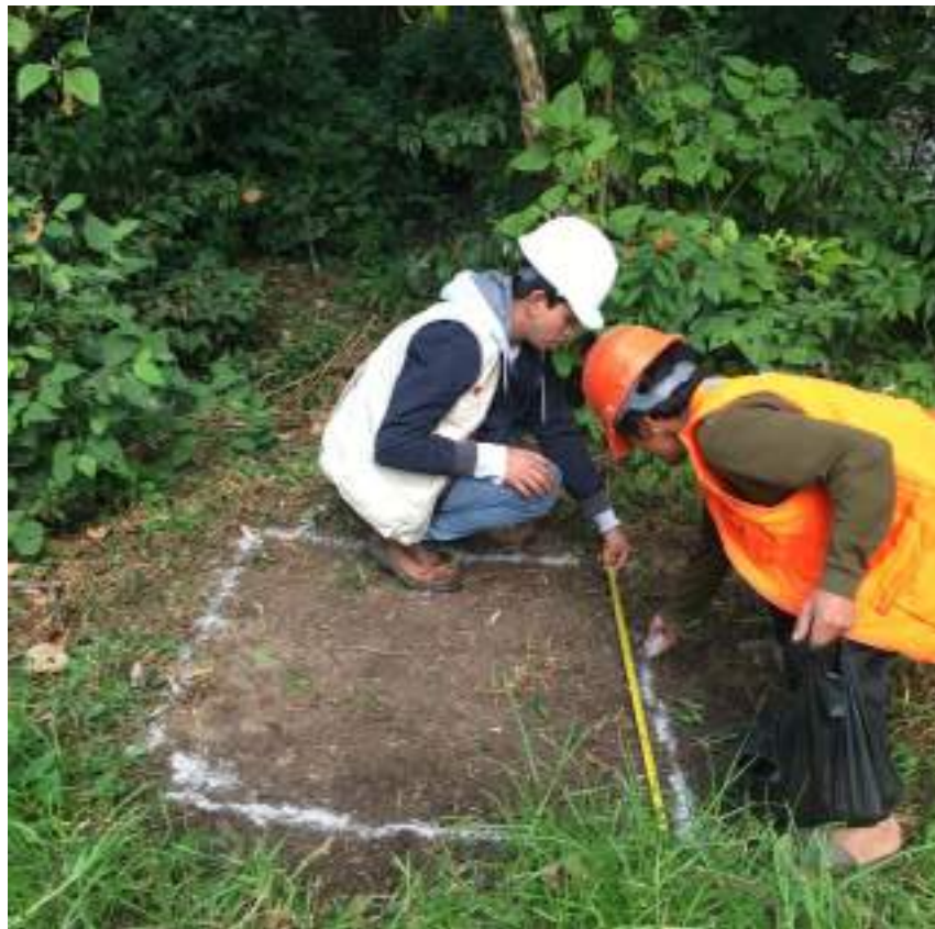
FOTO 04. TRAZO A 1m 2 PARA LA REALIZACION DE LA CALICATA
