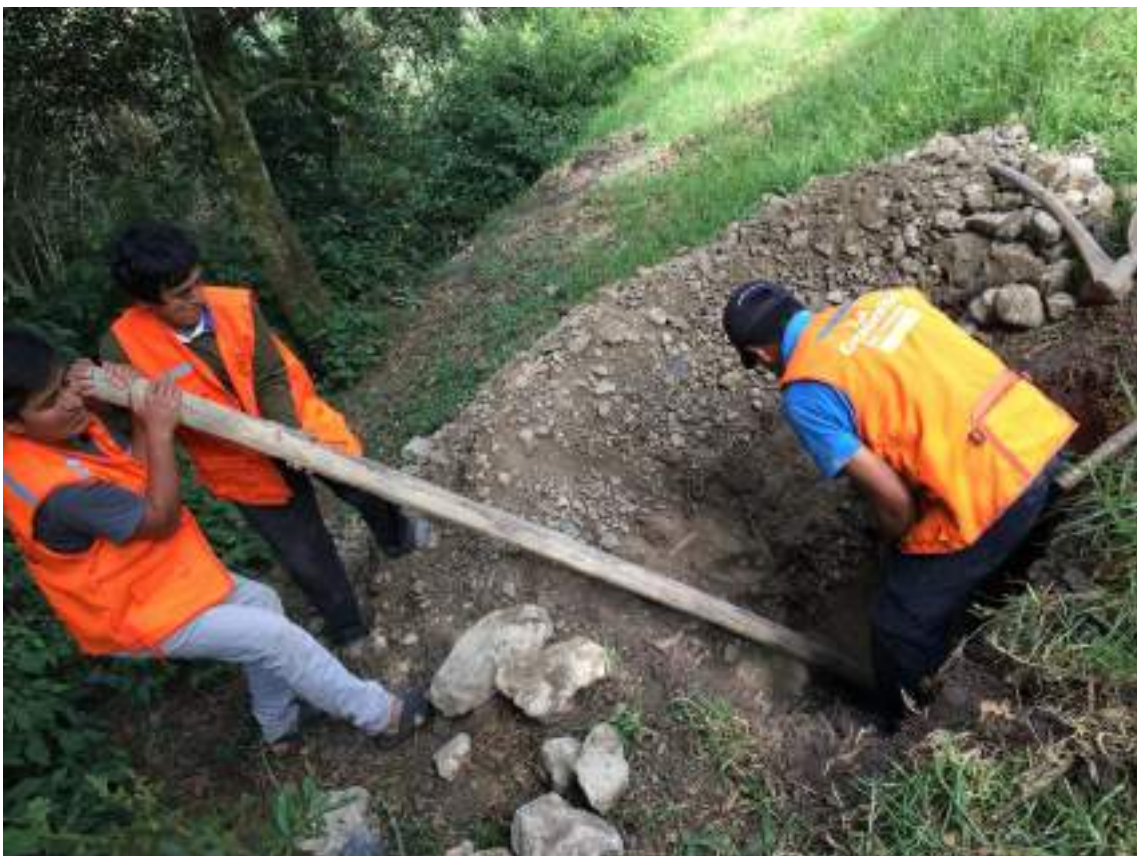
FOTO 18. EXCAVACION DE CALICATA
