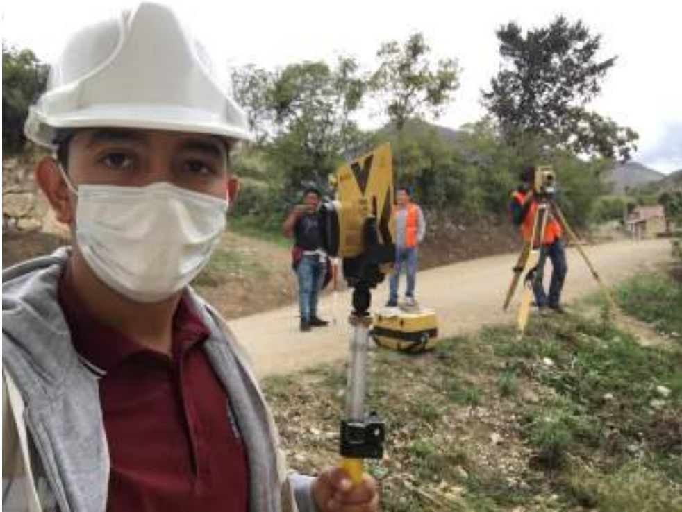
FOTO 13. LEVANTAMIENTO TOPOGRAFICO DE LA VIA DE ACCESO A LA PTAR
