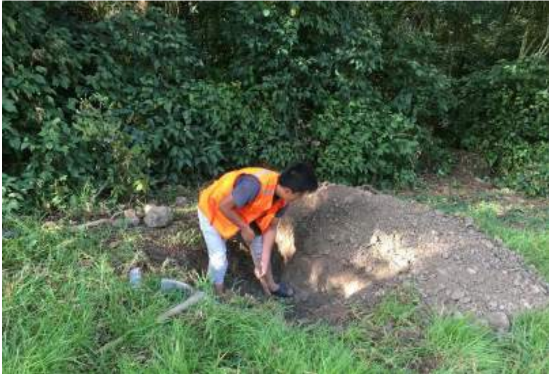
FOTO 15. EXCAVACION DE CALICATA
