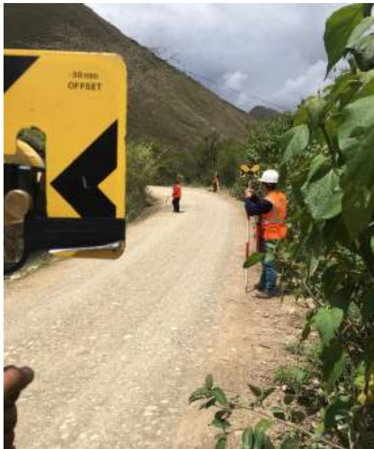
FOTO 14. LEVANTAMIENTO TOPOGRAFICO DE LA VIA DE ACCESO A LA PTAR
