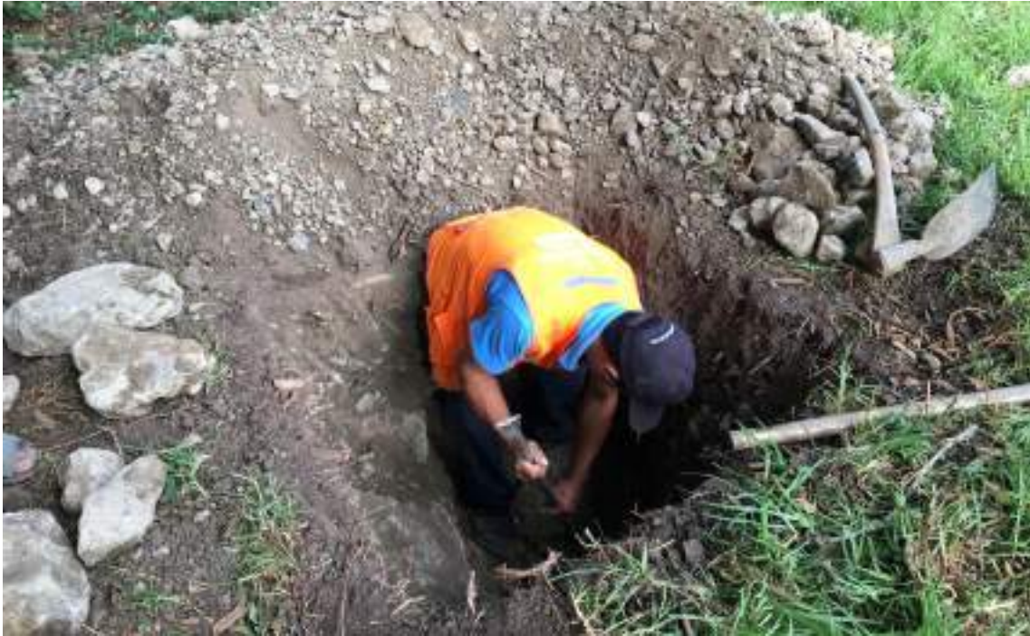
FOTO 17. EXCAVACION DE CALICATA
