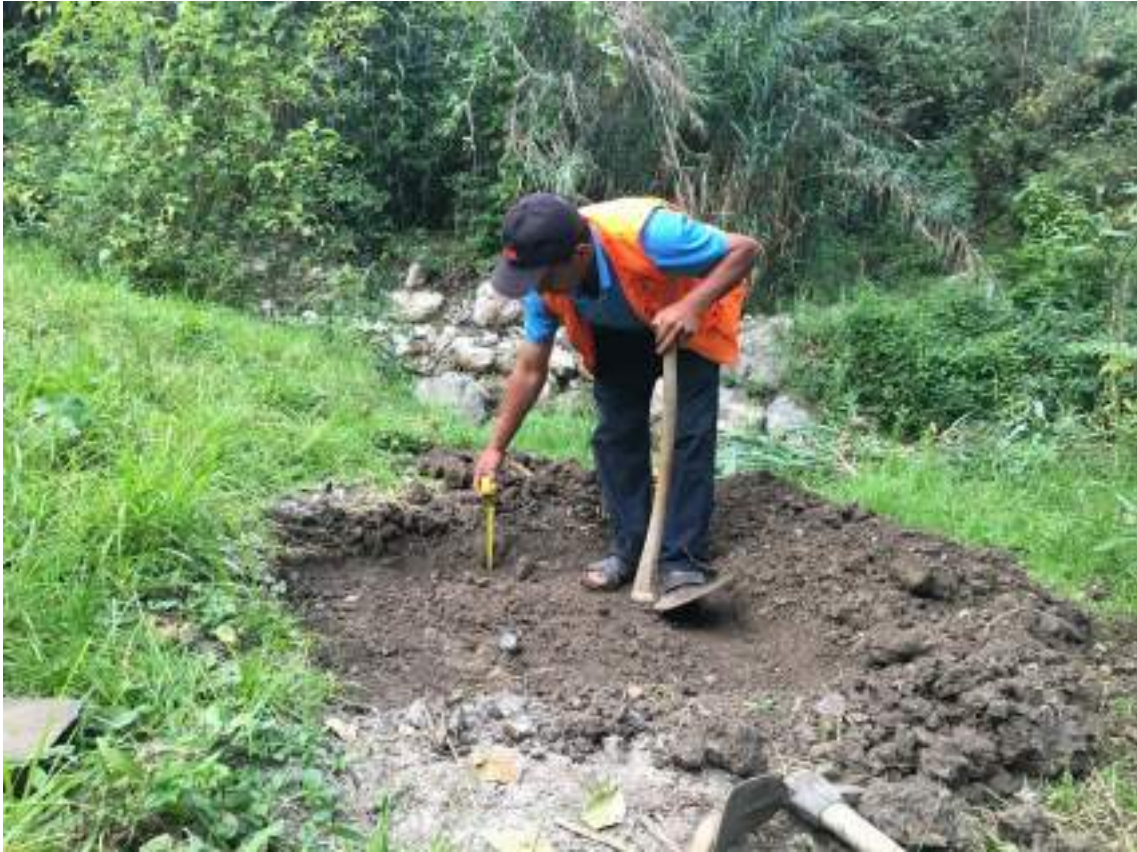
FOTO 11. MEDICION DE LA ALTURA DEL TERRENO NATURAL EN UN RANGO DE 20cm A 40cm
