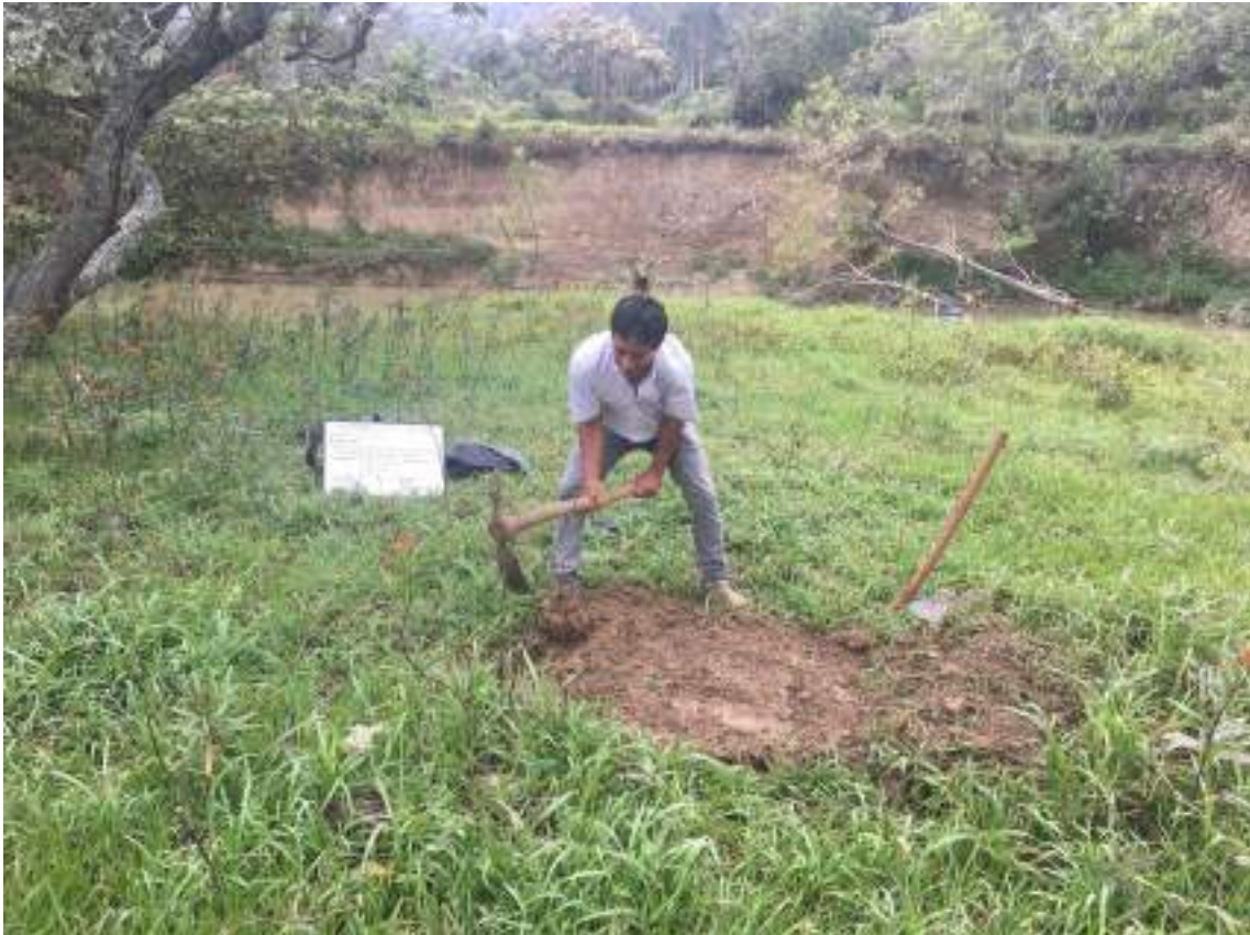
FOTO 26. LIMPIEZA DEL ÁREA DONDE SE REALIZARA LA CALICATA
