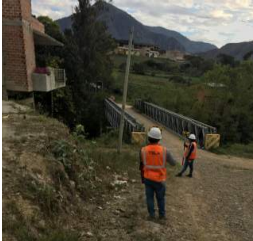
FOTO 11. LEVANTAMIENTO TOPOGRAFICO DE ESTRUCTURAS UBICADAS A LO LARGO DEL AMBITO DEL PROYECTO
