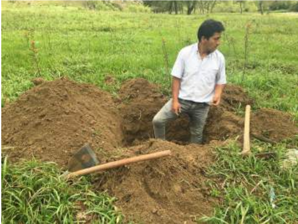
FOTO 27. EXCAVACION DE CALICATA
