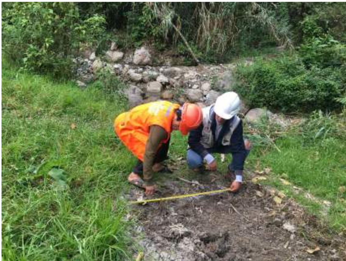
FOTO 08. TRAZO A 1m 2 PARA LA REALIZACION DE LA CALICATA
