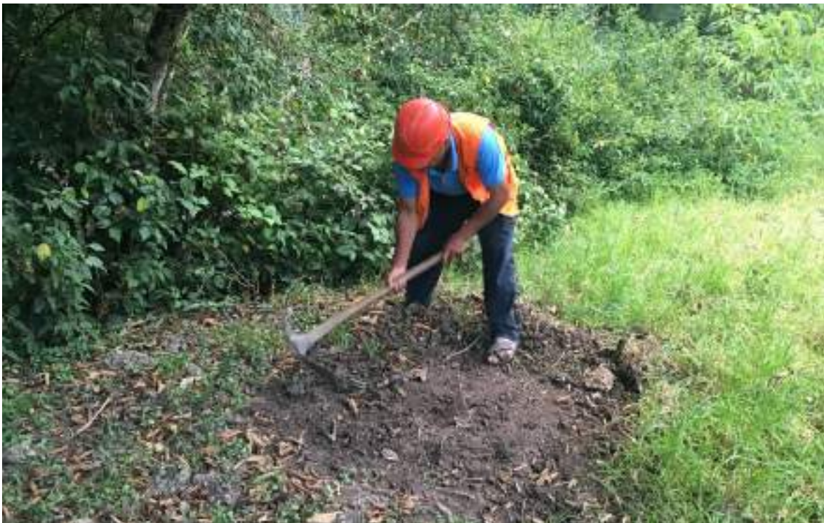
FOTO 02. LIMPIEZA DEL ÁREA DONDE SE REALIZARA LA CALICATA
