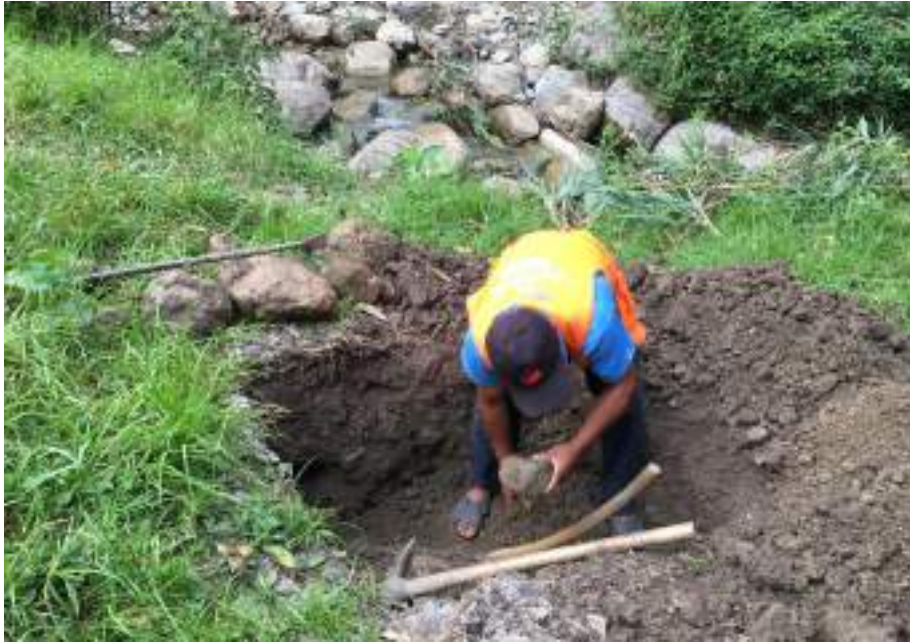
FOTO 13. EXCAVACION DE CALICATA
