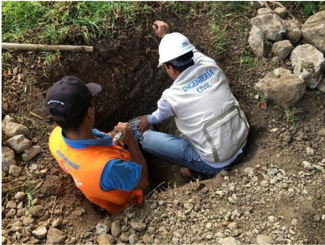
FOTO 21. EXTRACCIÓN DE MUESTRAS DE CALICATAS
