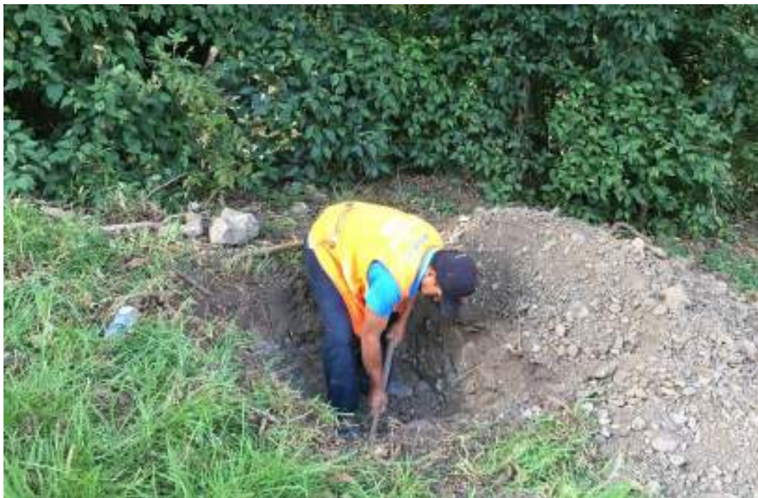
FOTO 16. EXCAVACION DE CALICATA
