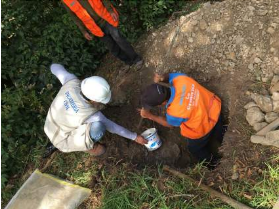
FOTO 19. EXTRACCIÓN DE MUESTRAS DE CALICATAS
