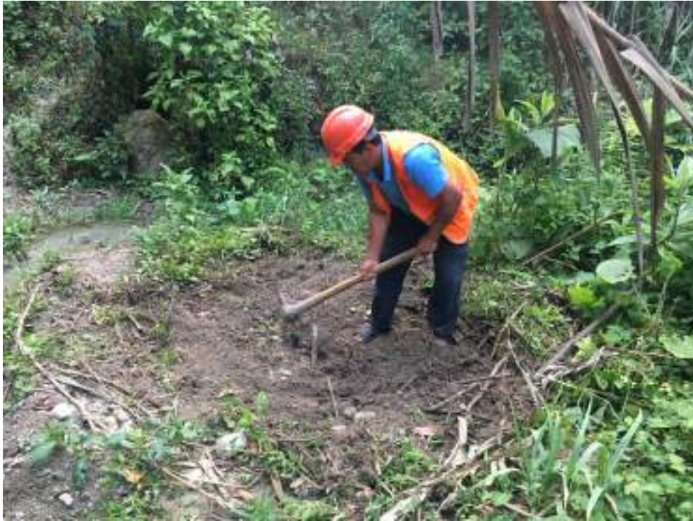
FOTO 03. LIMPIEZA DEL ÁREA DONDE SE REALIZARA LA CALICATA
