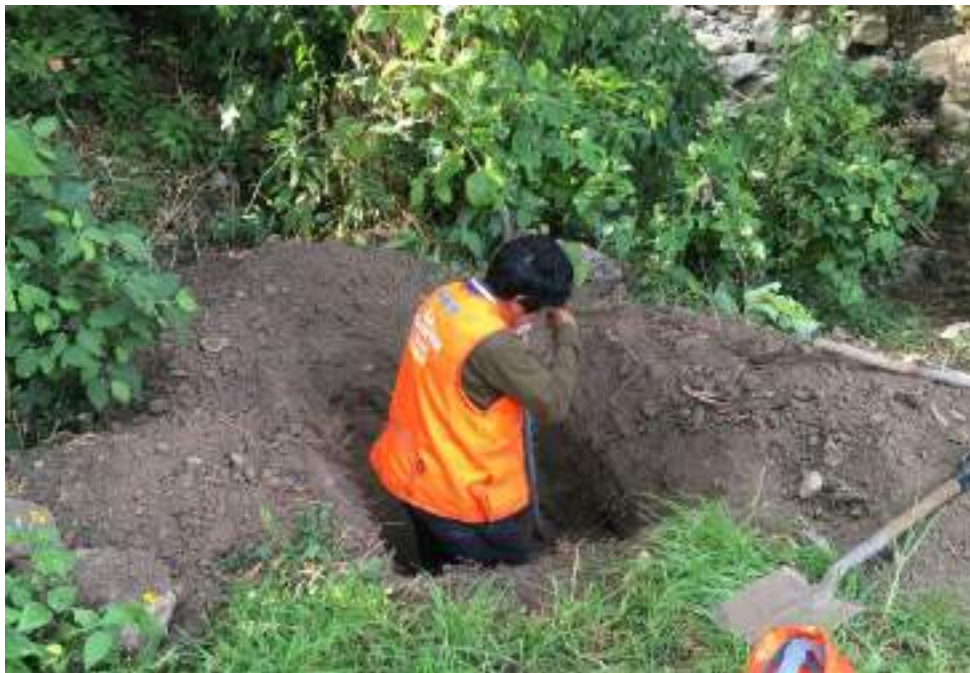
FOTO 14. EXCAVACION DE CALICATA
