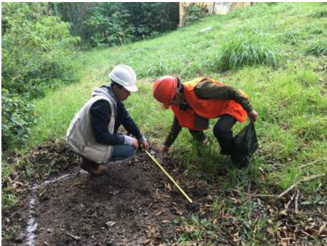
FOTO 06. TRAZO A 1m 2 PARA LA REALIZACION DE LA CALICATA
