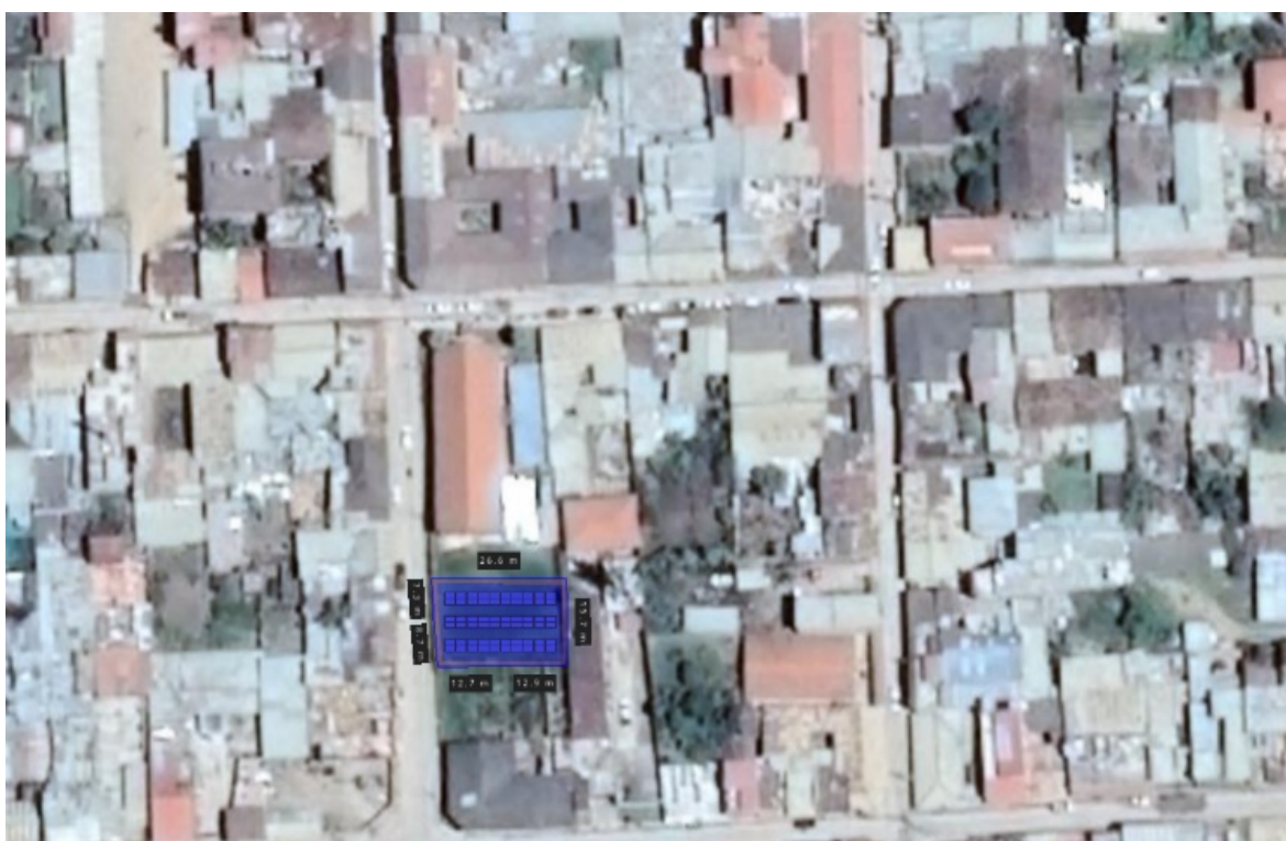
Figura 11. Central Fotovoltaica de 25kW en Subestación de Electroriente Chachapoyas de 160kVA ubicada en Jirón 2 de Mayo C-6 y Amazonas C-7.
