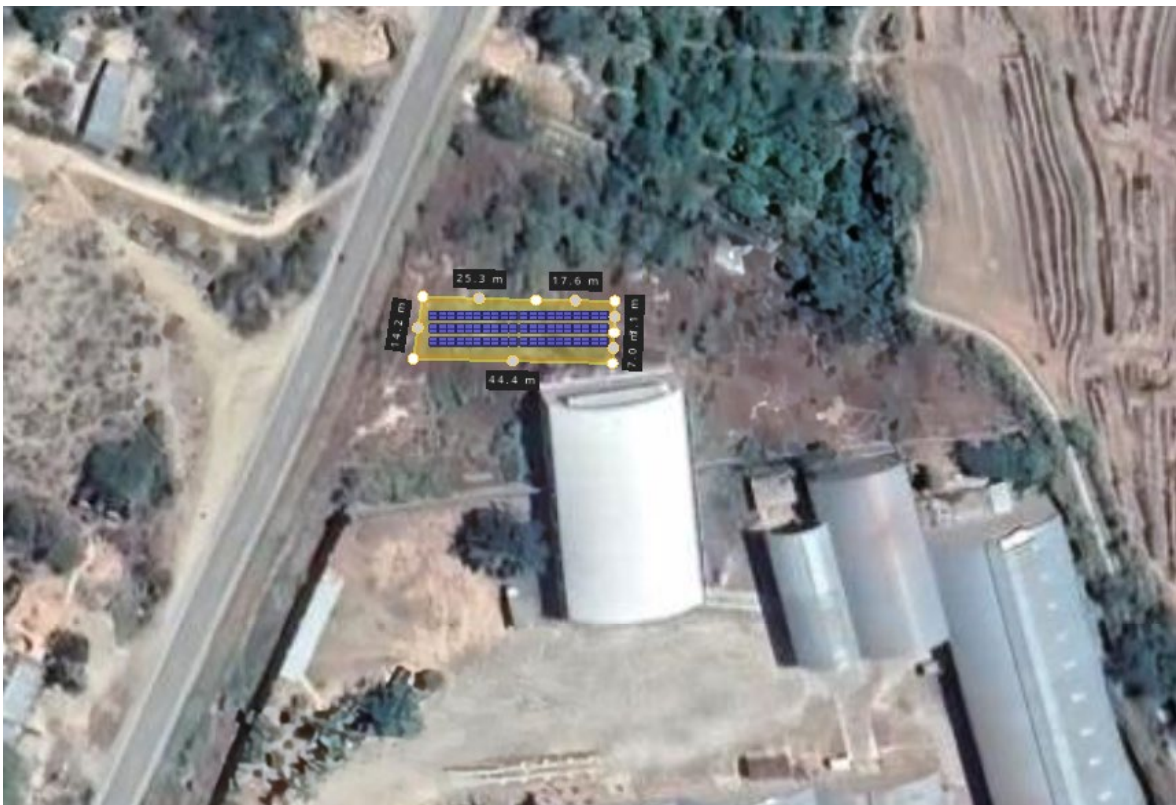
Figura 13. Central fotovoltaica de 50kW ubicada en Chamaya Coinca.
