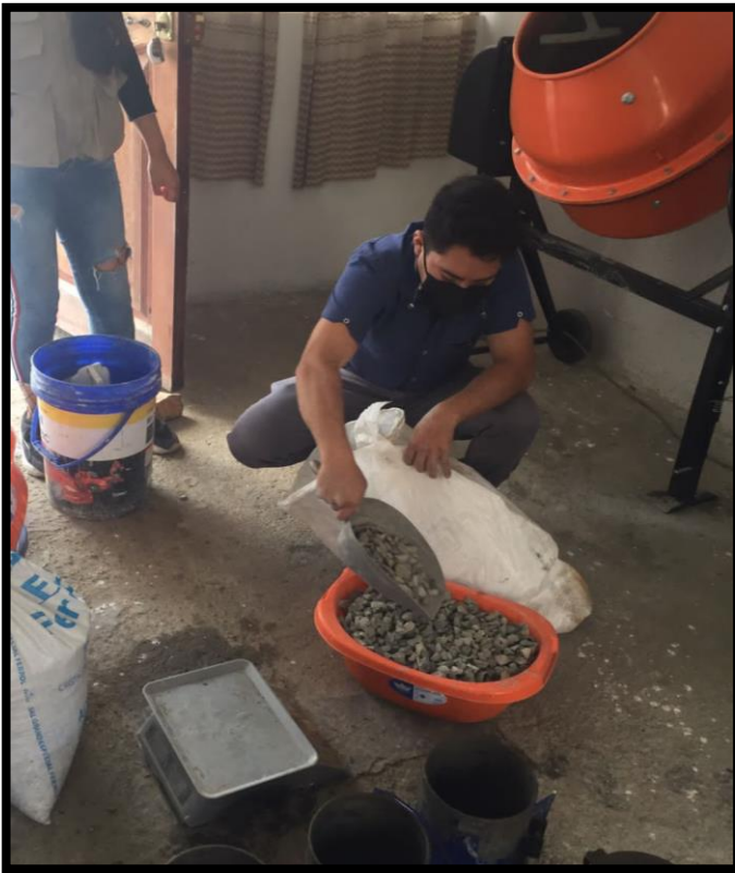
Fotografía 3: Realizando el peso de la piedra chancada para la mezcla de concreto
