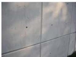
ACABADO DE CONCRETO APARENTE
