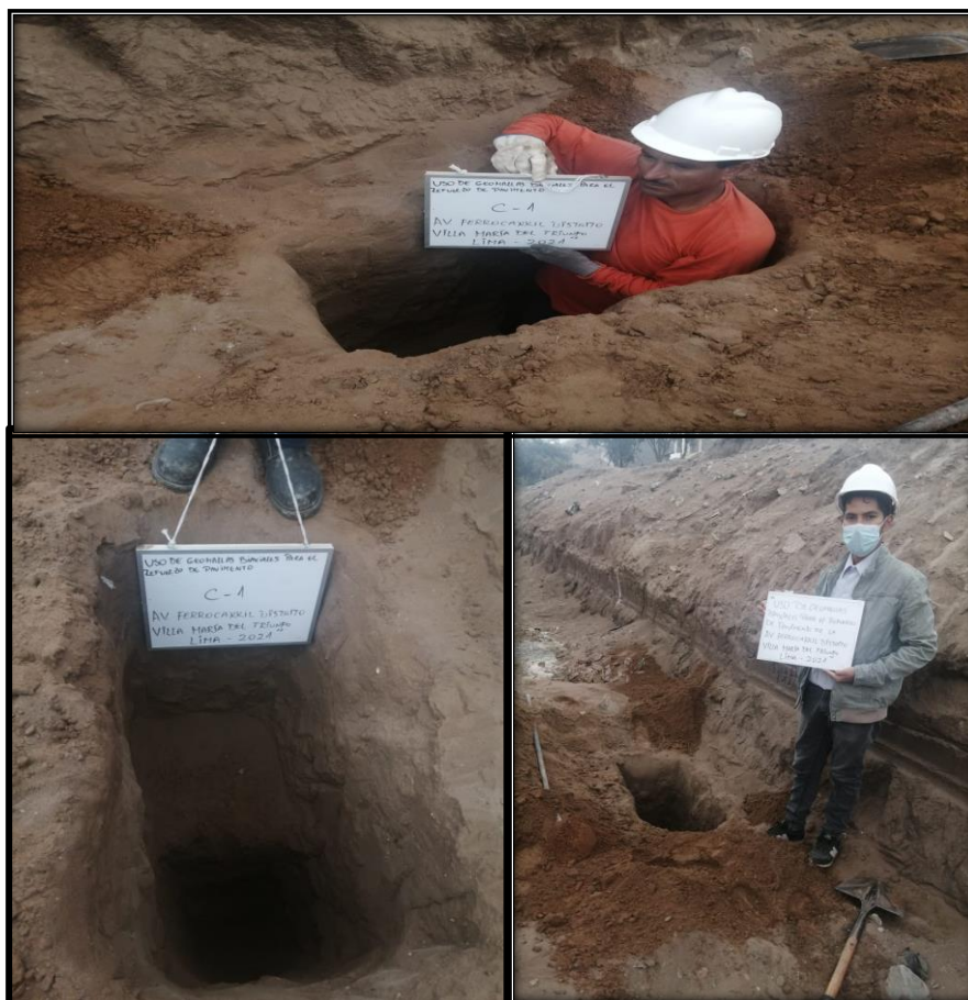
Figura 1. Realización de Calicata N°1 Fuente: Elaboración propia
