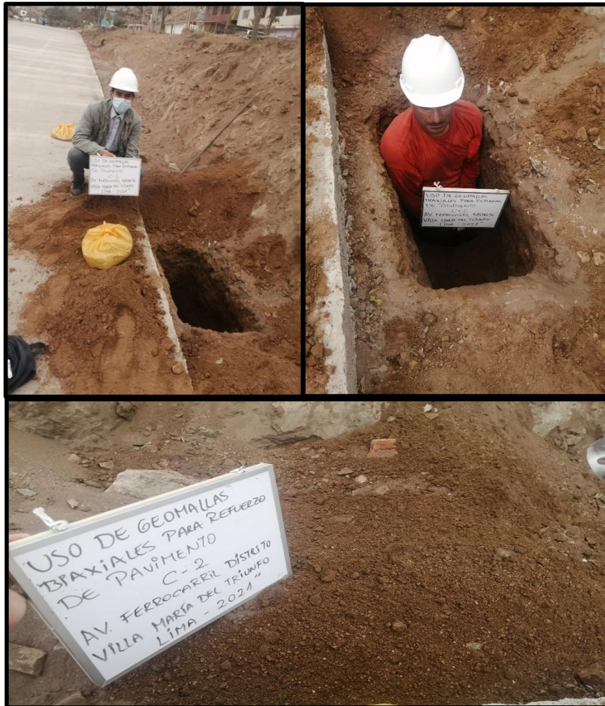
Figura 2. Realización de Calicata N°2 Fuente: Elaboración propia
