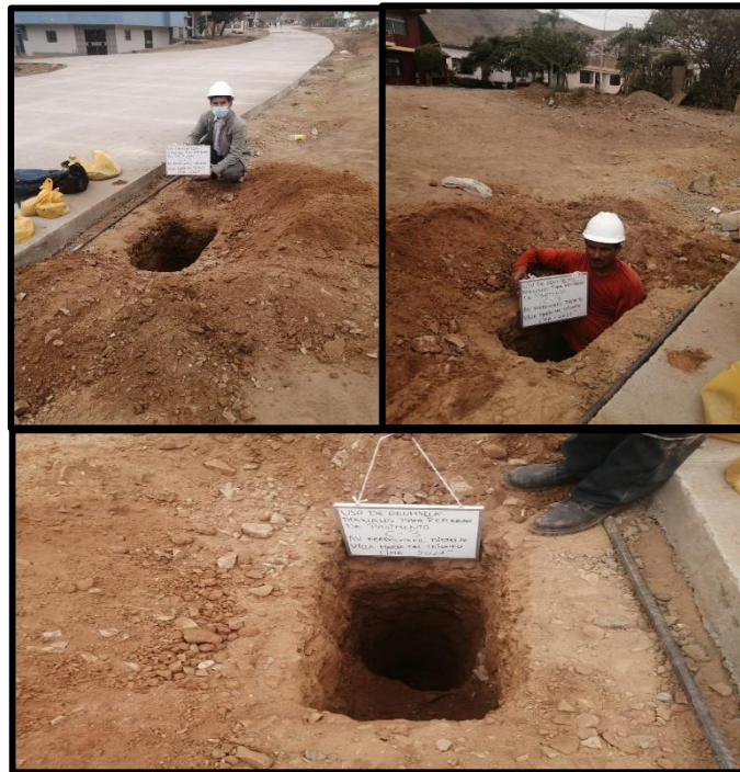
Figura 3. Realización de Calicata N°3 Fuente: Elaboración propia
