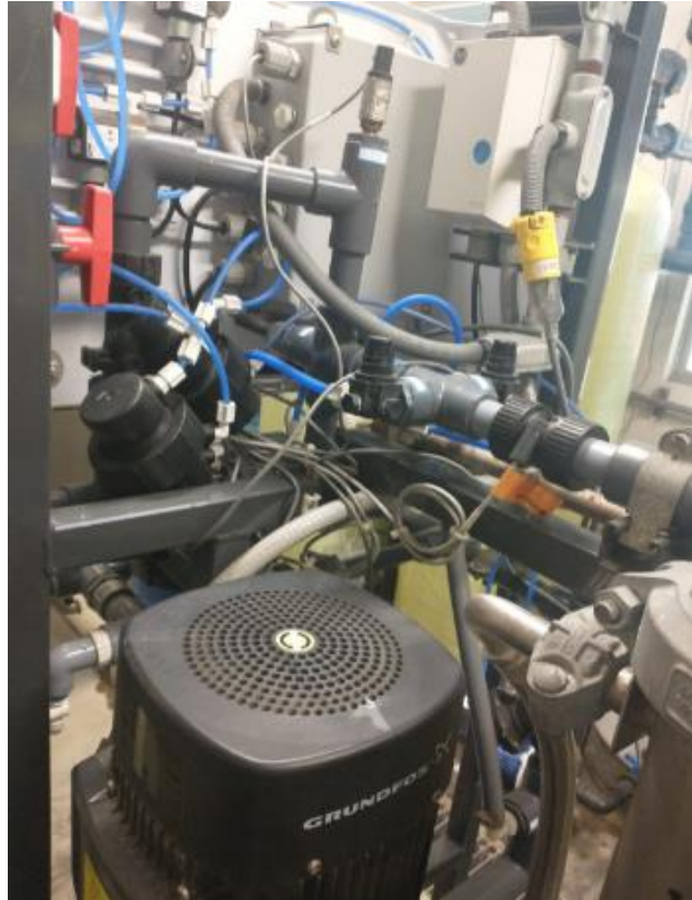
Figura 8. Inspección a equipo de Osmosis
