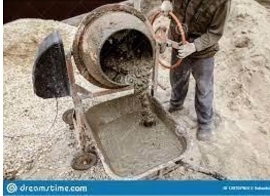
*Figura 16. Mezclado mecánico del concreto*
