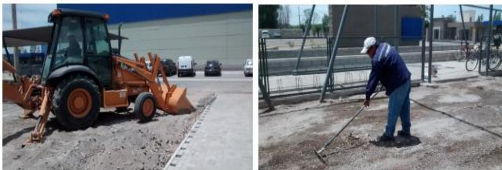
*Figura 25.* Se observa los trabajos realizados para subrasante
