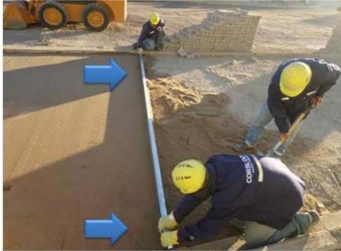
Figura 29. Uniformidad de la superficie a colocar adoquín.
