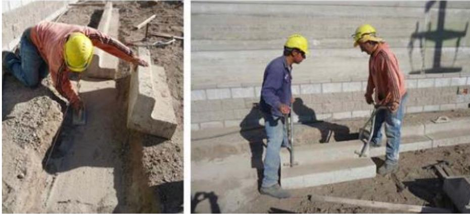
Figura 26. Se observa el confinamiento de adoquín de concreto
