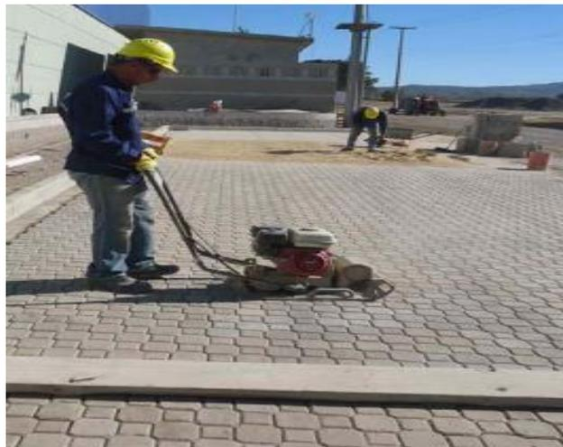
*Figura 34. Compactación de los adoquines*
