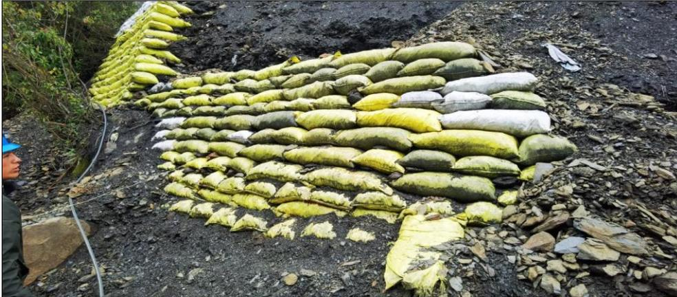
*Figura 1.* Se observa el muro de contención realizados con relleno de relave embolsados en sacos esto para poder almacenar grandes cantidades de relave en su superficie.
