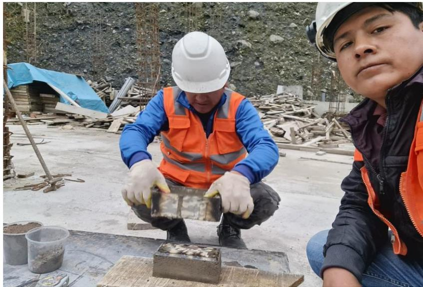
*Figura 56.* Se observa el moldeado del adoquín de concreto
