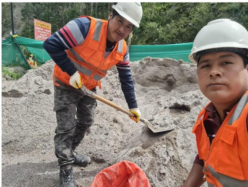
*Figura 46.* Toma de muestra del agregado fino cantera Macusani
