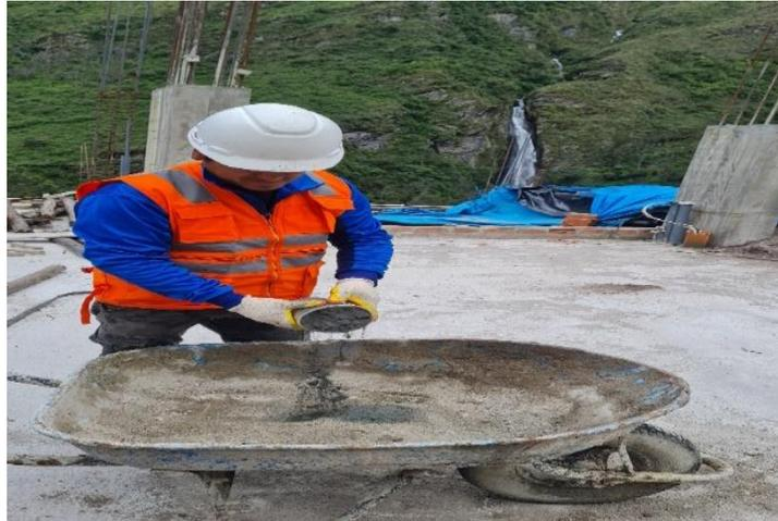
*Figura 54.* Se observa realizando la mezcla de relave con cemento y arena.
