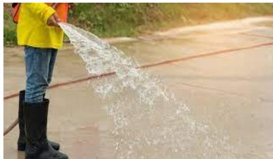
*Figura 19.* Se observa el curado de adoquines de concreto
