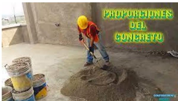
*Figura 15. Mezclado manual del concreto*
