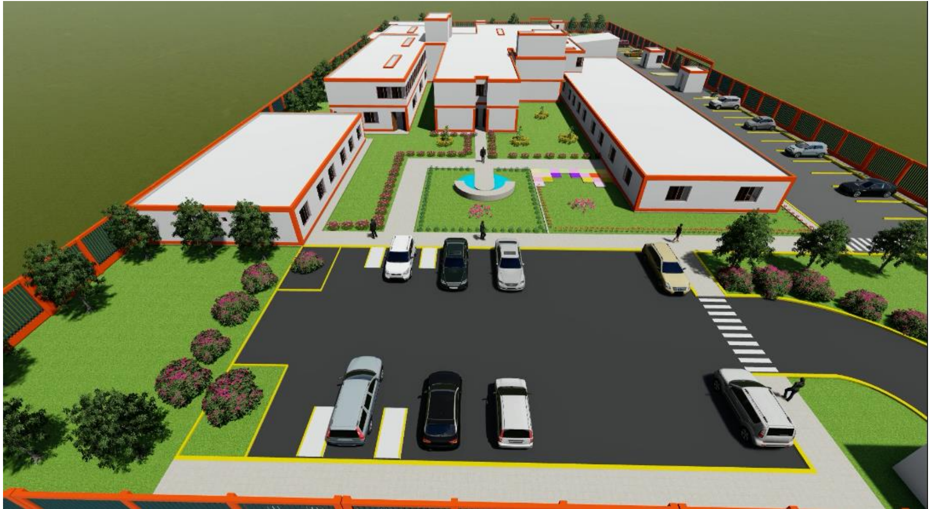
FACHADA LATERAL IZQUIERDA –CENTRO DE SALUD
