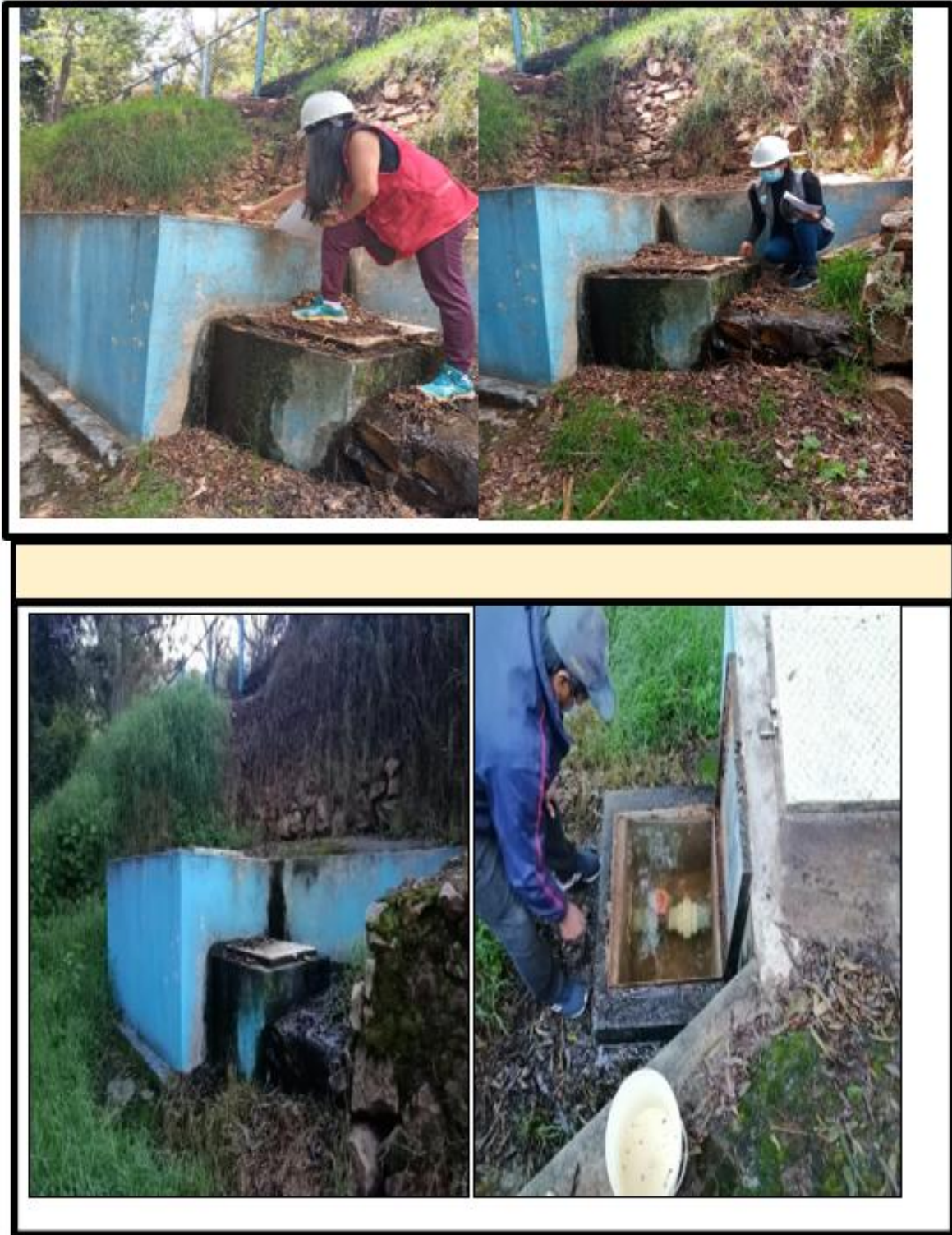
Imagen N°01: Estado actual de la captación Totora Huran.
