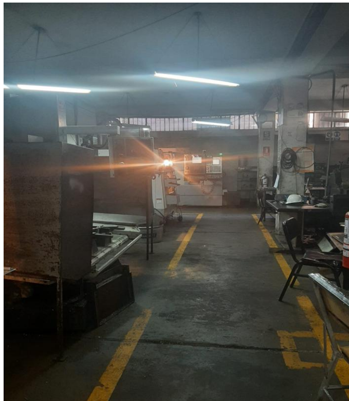
Figura 16. Instalación de Fluorescente de tubo doble en la estación de Desbaste de la Pieza.
