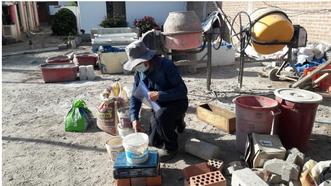
Figura 3. Realizando los respectivos pesos de los agregados, cemento y agua para la mezcla patrón del concreto. Fuente: Elaboración propia.
