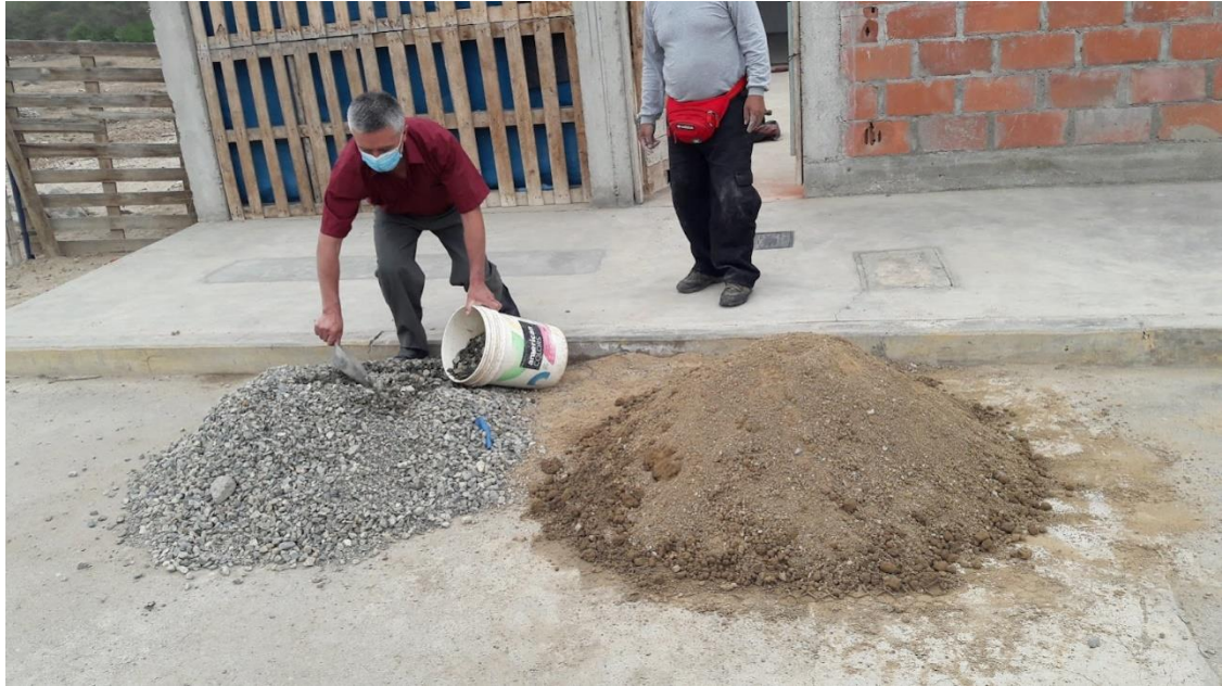
Figura 9. Acarrear el agregado grueso fino y grueso hacia la mezcladora para realizar la mezcla de concreto.
