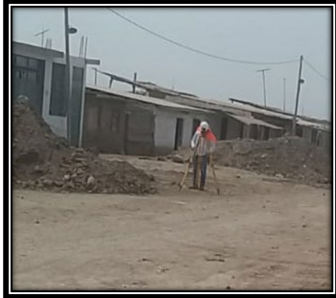
Foto N° 06.- Se aprecia al topógrafo ubicando el BM N°12, al lado del camino.
