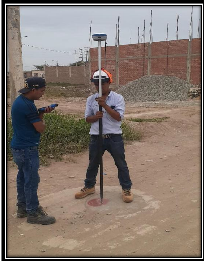
Fotografía N°16: Levantamiento de buzones existentes.
