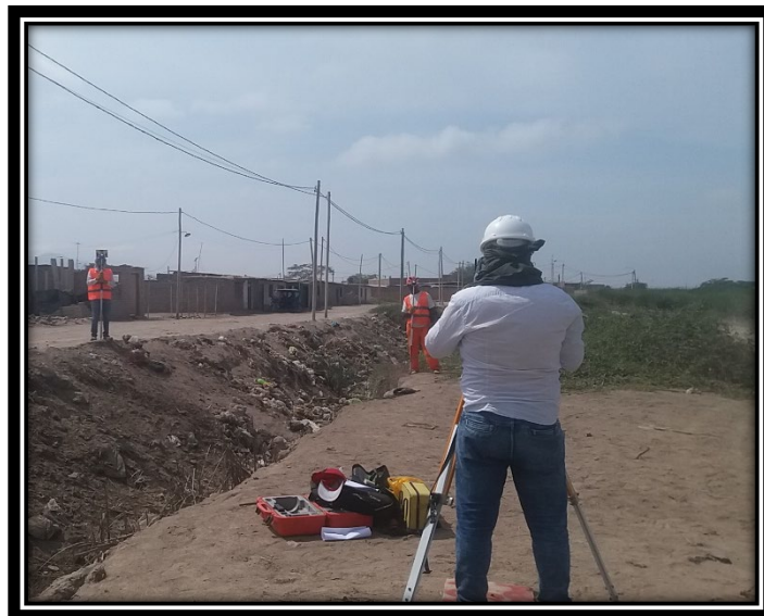
Foto N° 01.- Observamos el levantamiento del dren en la “ET-07”, el cual es uno de los puntos de control encontrados dentro del proyecto, sirvió para hacer la orientación con la estación total al punto de apoyo “B-02”
