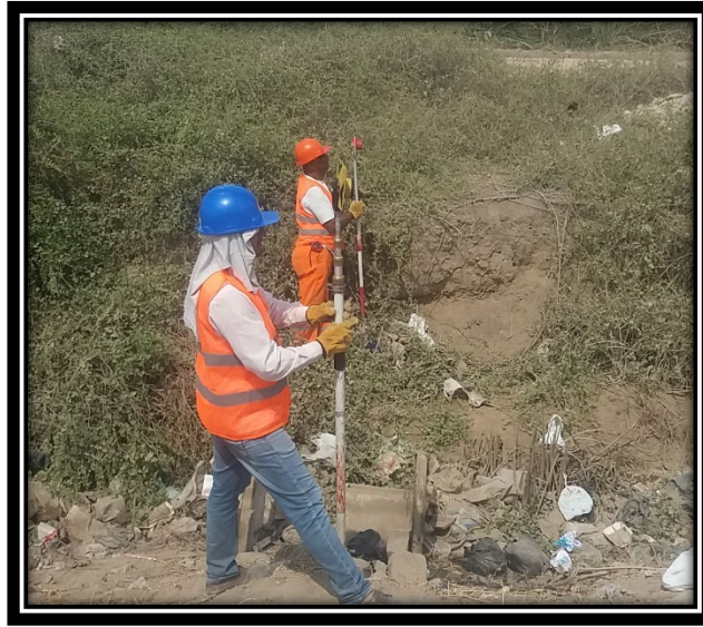
Foto N° 02.- Se aprecia dos ayudantes de topografía, nivelando el bastón para el levantamiento topográfico que se encuentra realizando de la vía principal de la carretera principal a la Habilitación Urbana Puertas de Chiclayo.
