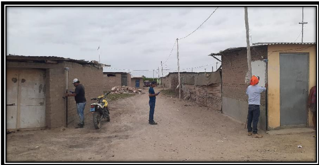
Fotografía N°17: Levantamiento de viviendas existentes
