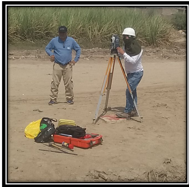
Foto N° 03.- Se aprecia el topógrafo en la estación total, ubicado frente del terreno del SECTOR 31A, donde se está realizando el levantamiento topográfico, y al costado una seguridad que se adquirió durante todo el estudio topográfico del proyecto.
