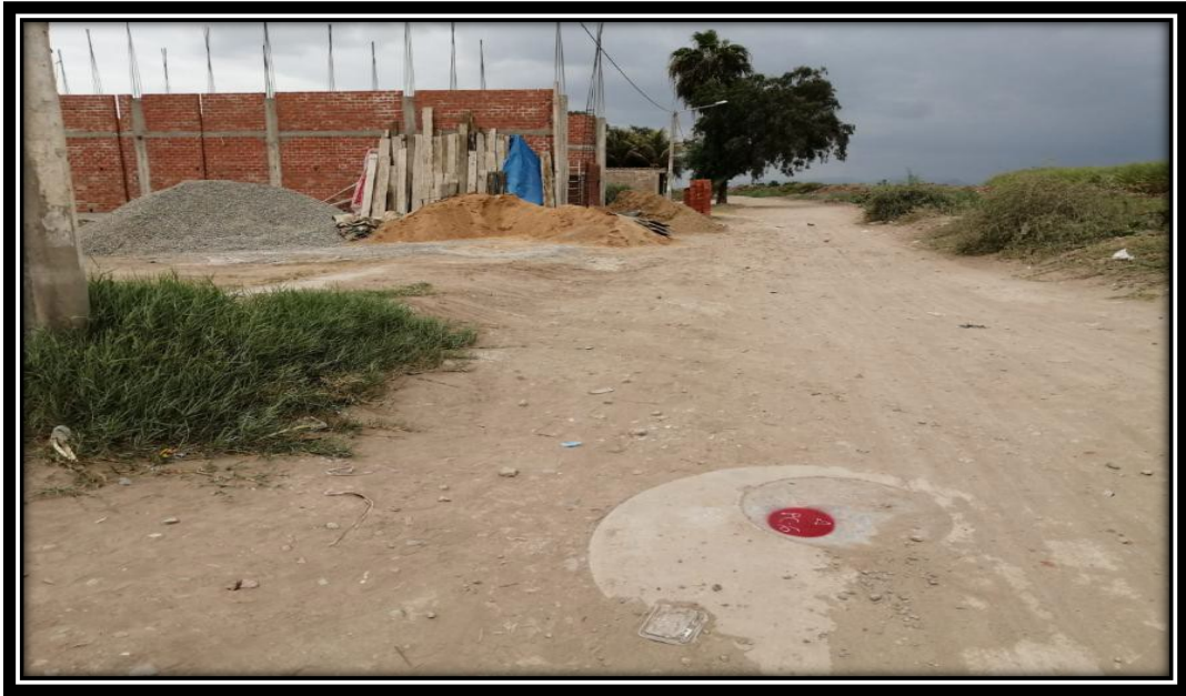
Fotografía N°13: Levantamiento de puntos de control ( PC-6).
