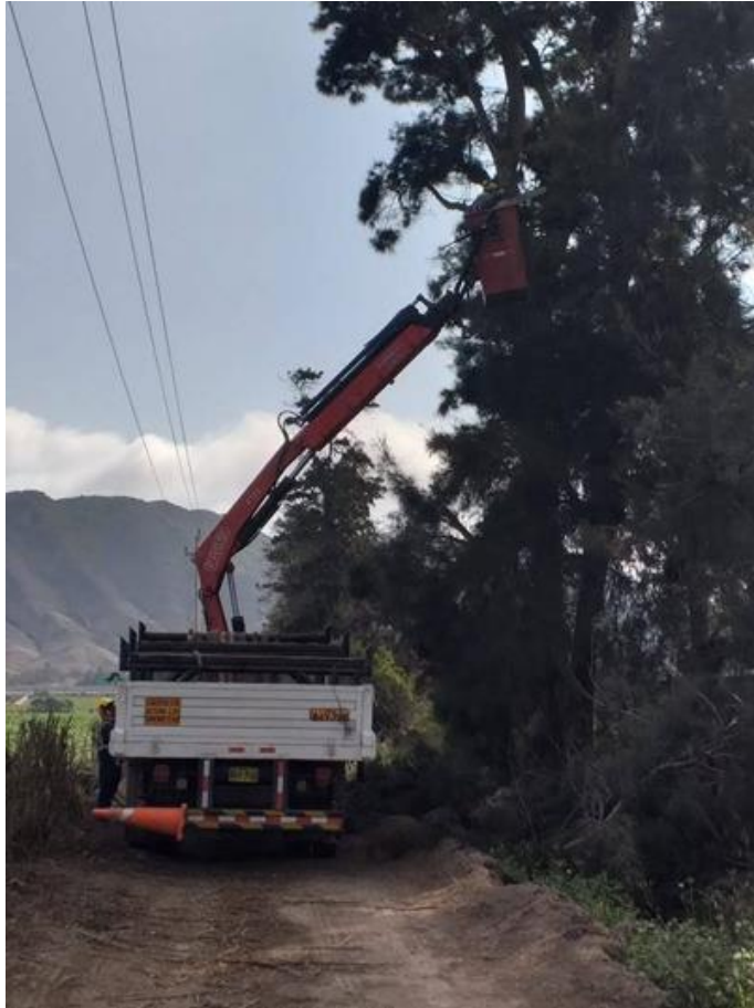
Figura 13 Trabajos con grúa
