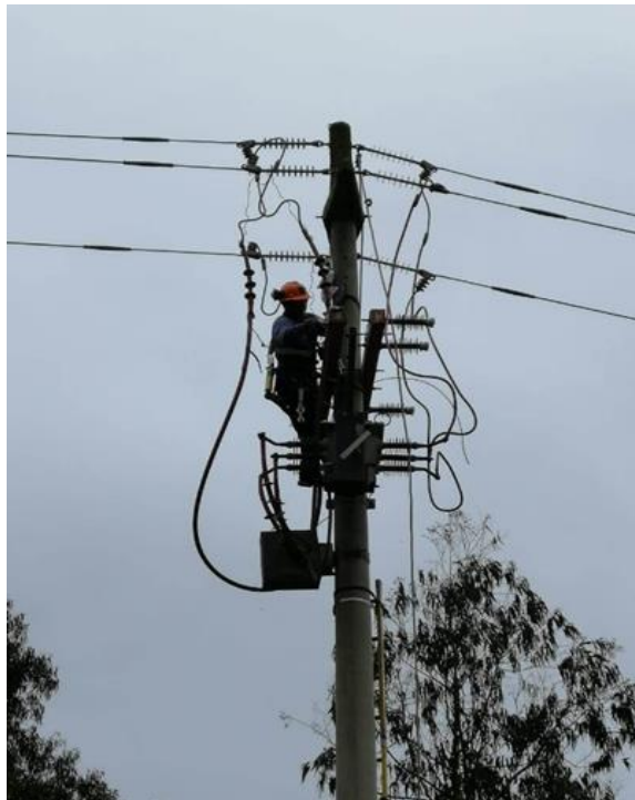
Figura 12 Instalación de equipos en media tensión
