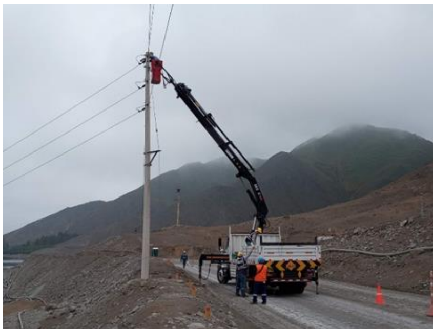
Figura 14 Instalación de conductores en media tensión
