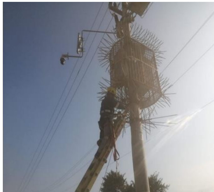
Figura 10 Trabajos de mantenimientos
