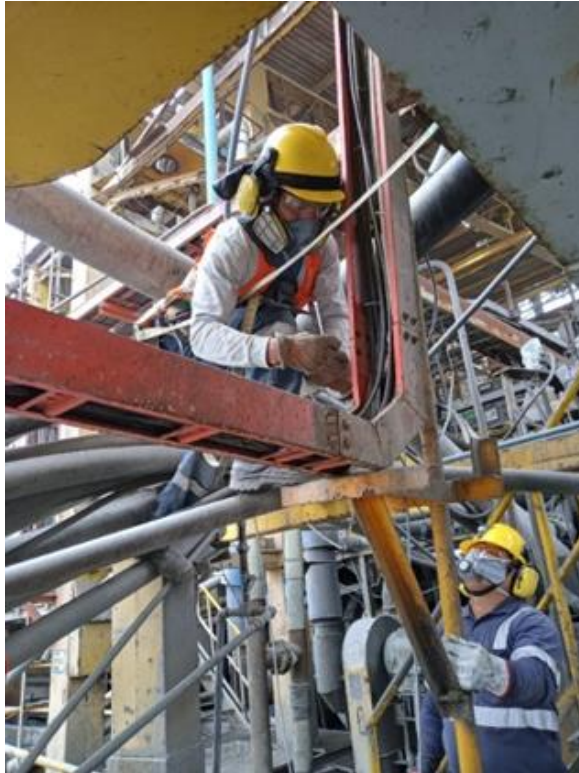
Figura 11 Instalación de cables de baja tensión.
