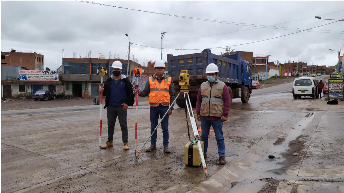
Fotografía 07: Equipo para inicio de levantamiento topográfico.
