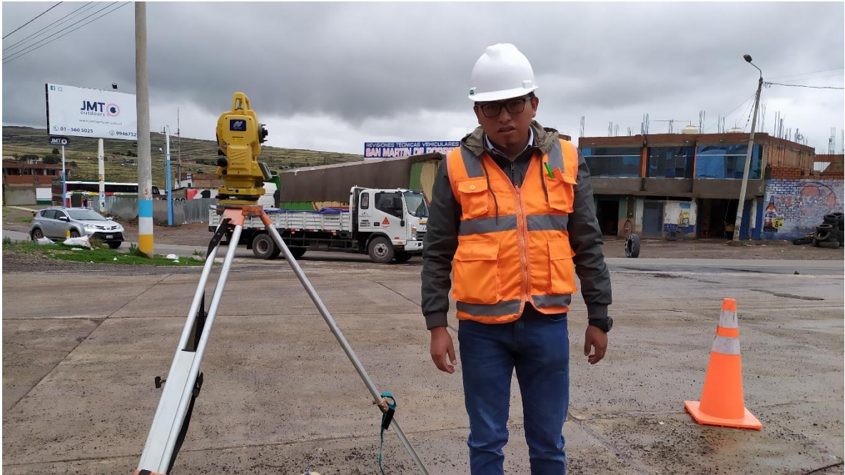
Fotografía 09: Punto de Control 01 levantamiento topográfico intersección.
