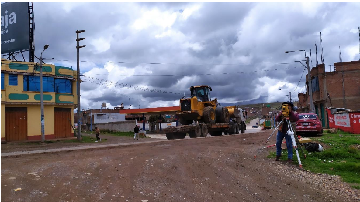
Fotografía 08: Levantamiento topográfico Av. Juliaca Noreste.
