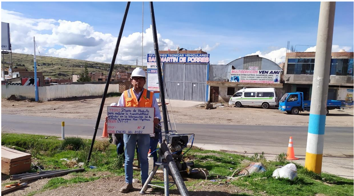
Fotografía 12: Ubicación de penetración estándar sondaje SPT-01.
