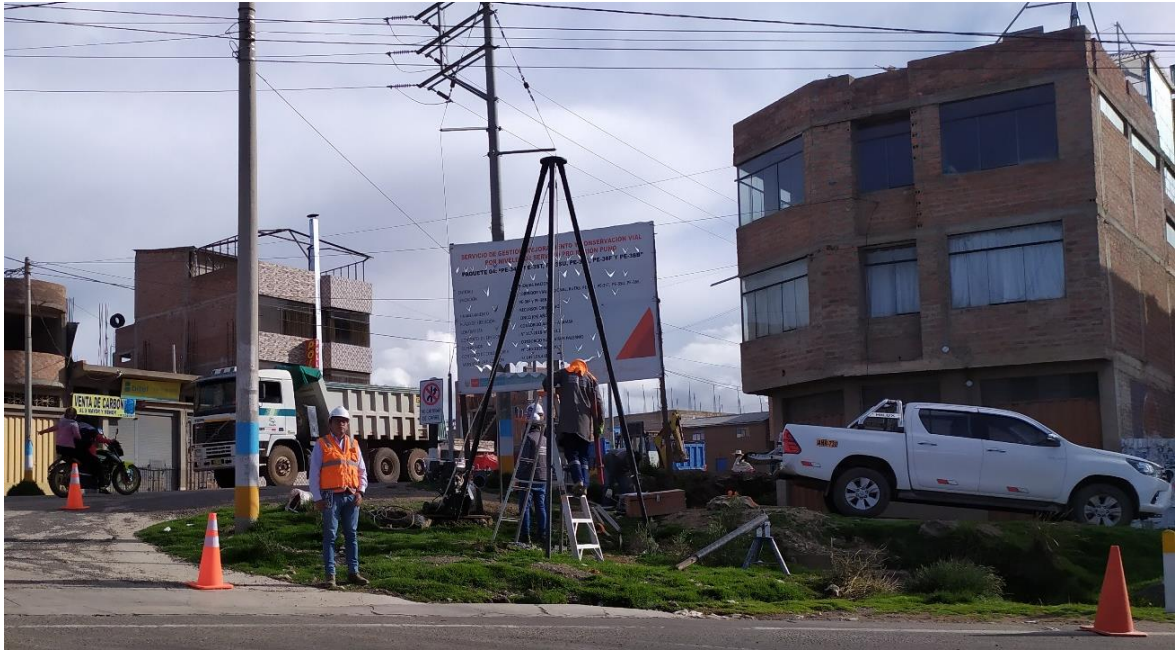
Fotografía 15: Ubicación de ensayo de penetración estándar sondaje SPT-01.
