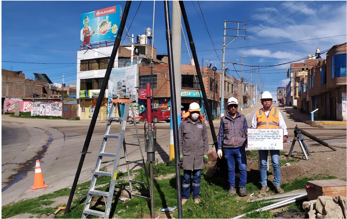
Fotografía 11: Equipo de ensayo de penetración estándar sondaje SPT-01.
