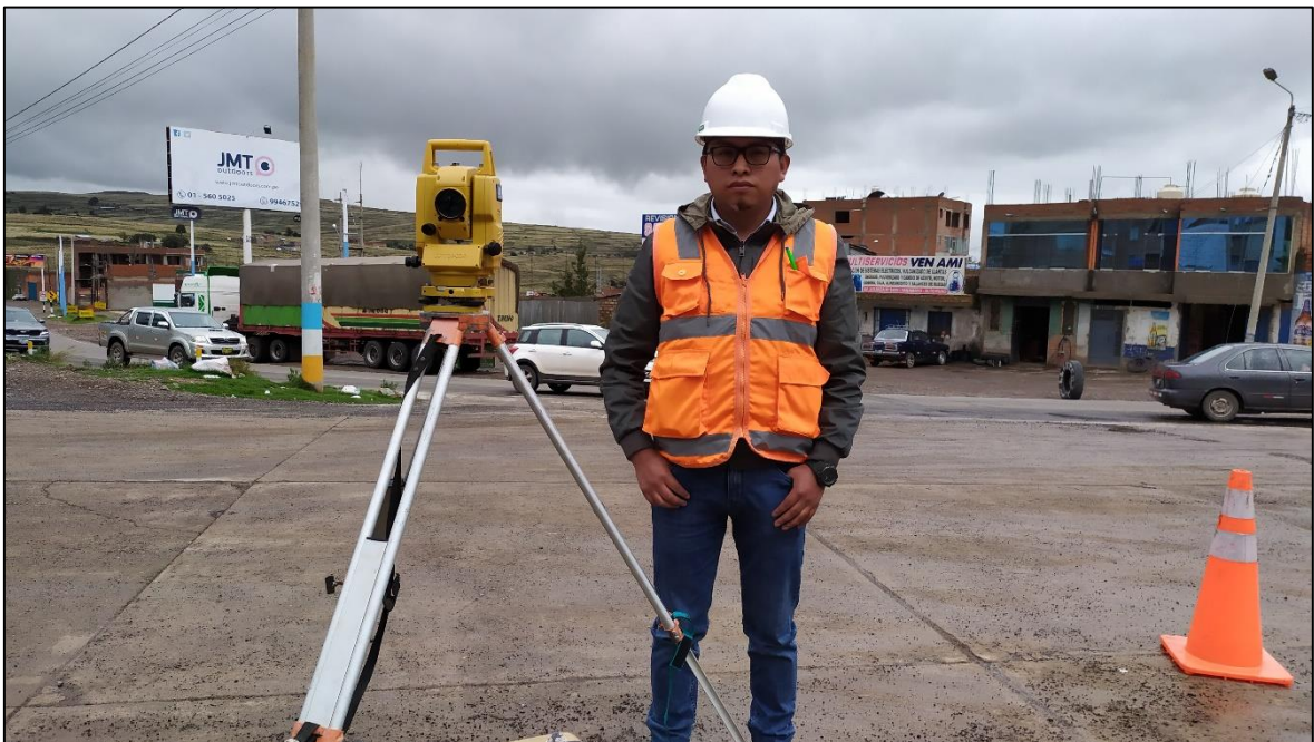
Figura 22: Desarrollo de levantamiento topográfico con estación total.
