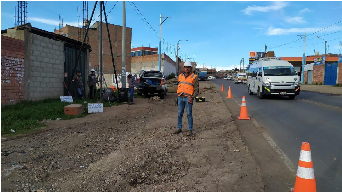
Fotografía 17: Ubicación de ensayo de penetración estándar sondaje SPT-02.
