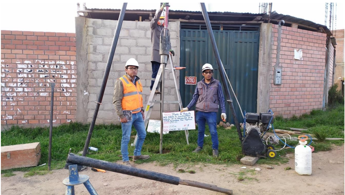
Fotografía 18: Equipo de ensayo de penetración estándar sondaje SPT-02.
