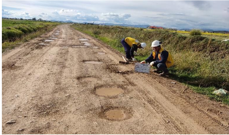
Figura 7. Paso 2. Se inicio de la elaboración de la calicata en el km 4+30 del tramo Taraco – Huancollusco
