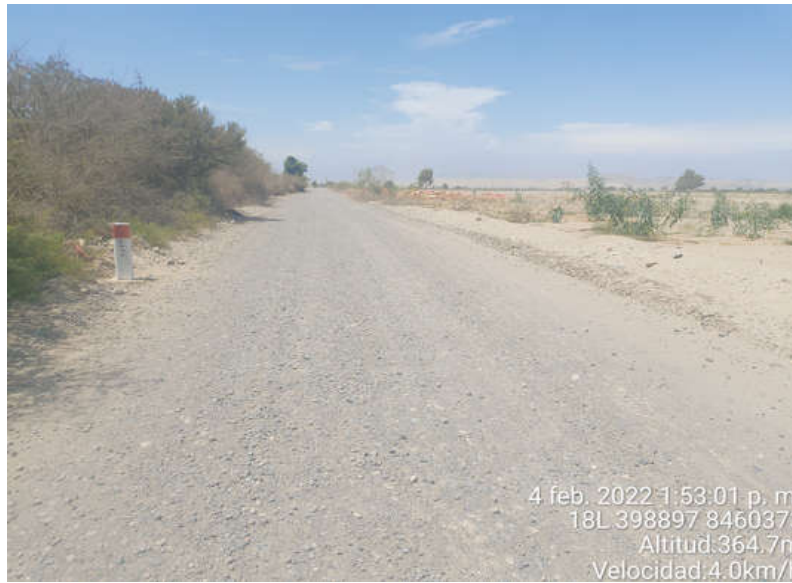
Figura 18. Superficie de Rodadura KM-00+624 al KM-00+634, se observa el daño de Encalaminado en la calzada.
