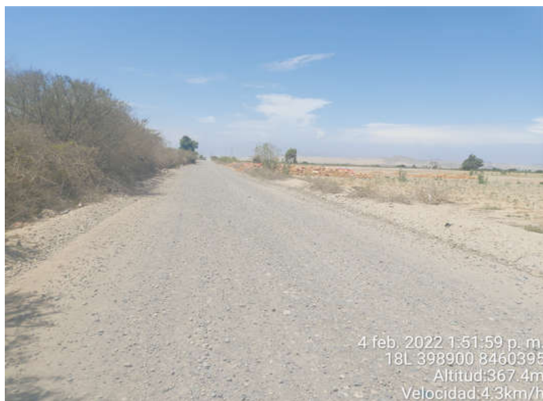
Figura 20. Superficie de Rodadura KM-00+644 al KM-00+654, se observa el daño de Encalaminado en la calzada.
