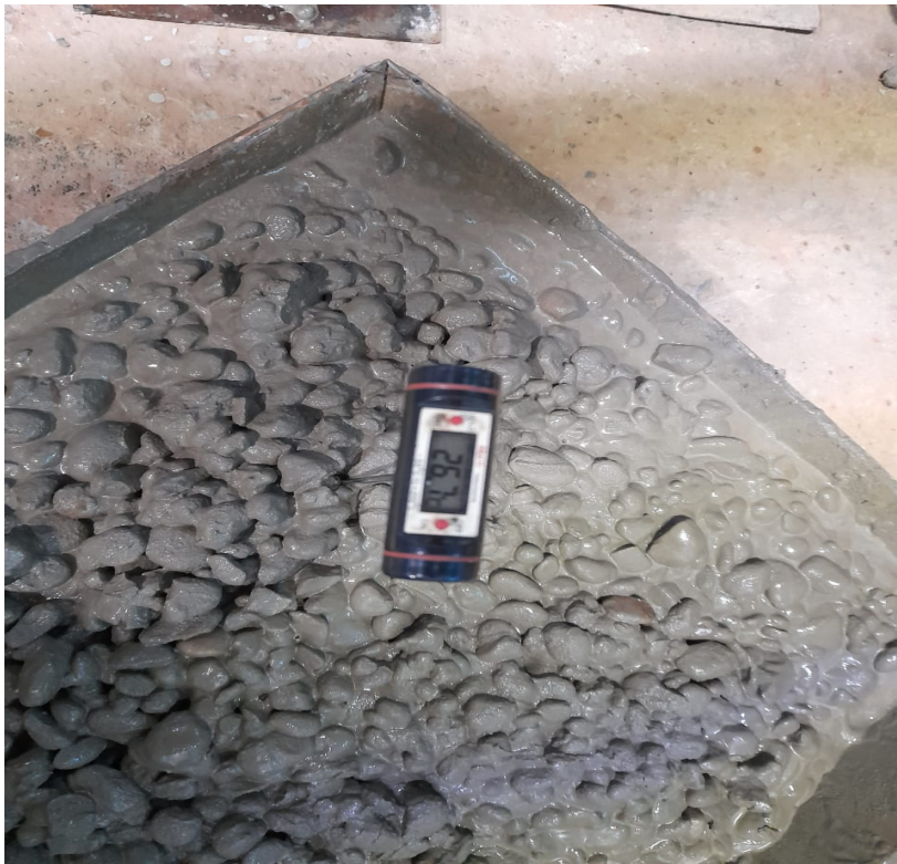
FOTO N° 11: Control de temperatura del concreto
