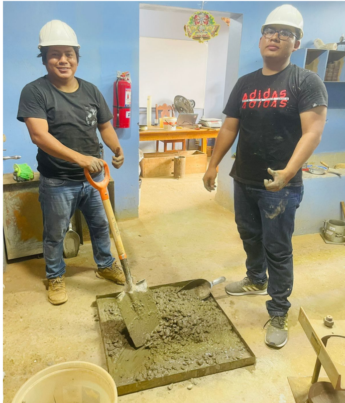
FOTO N° 12: Elaboración de la mezcla de concreto
