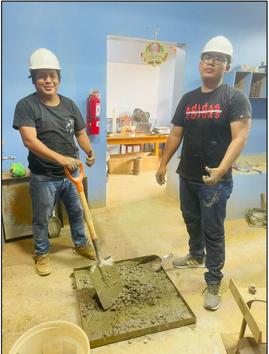
Figura 20. Mezclado del concreto
